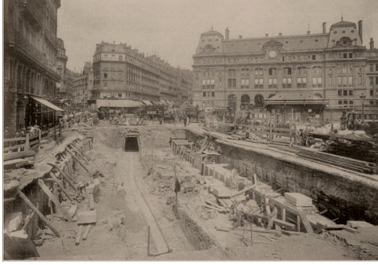
Resim 2.1. St. Lazare metro istasyonu, Paris, 1903. Aç-kapa kazı yöntemi ile yapılan kazıdan görüntüler [31]
