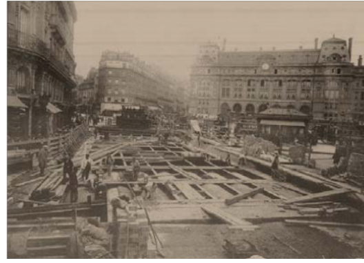
Resim 2.1. St. Lazare metro istasyonu, Paris, 1903. Aç-kapa kazı yöntemi ile yapılan kazıdan görüntüler [31]
