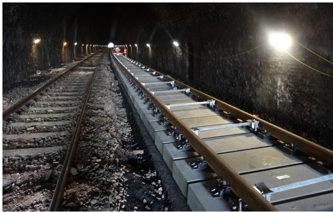
Resim 3.3. Balastlı ve balastsız demiryolu hattı [71]
