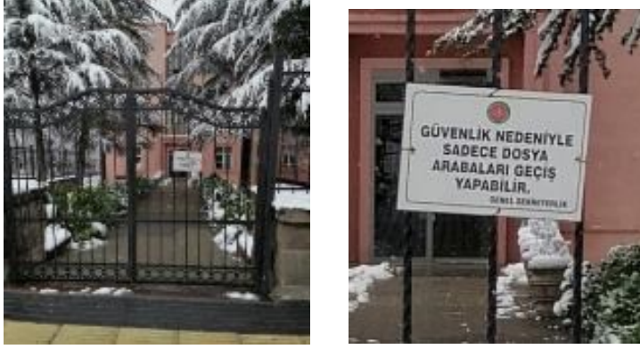
Resim 4.44. Eski Yargıtay Ana Binasının Vekâletler Caddesi üzerinde bulunan, binalar arasında taşınan dosyalar için kullanılan servis girişi (solda) ve yazı detayı (sağda) (Yazara ait, 2020)
