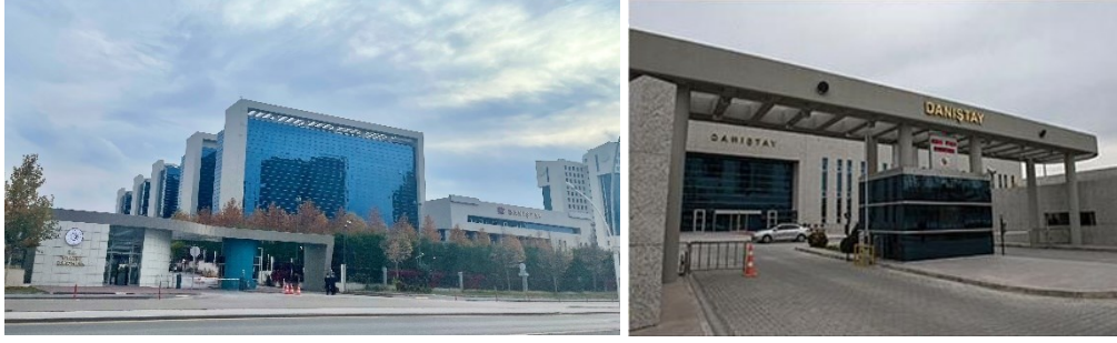
Resim 4.29. Danıştay binası a. Eskişehir yolu cephesinden görünüm (Wikimedia, 2022); b. ana giriş cephesinden görünüm (Anadolu Ajansı, 2014)
