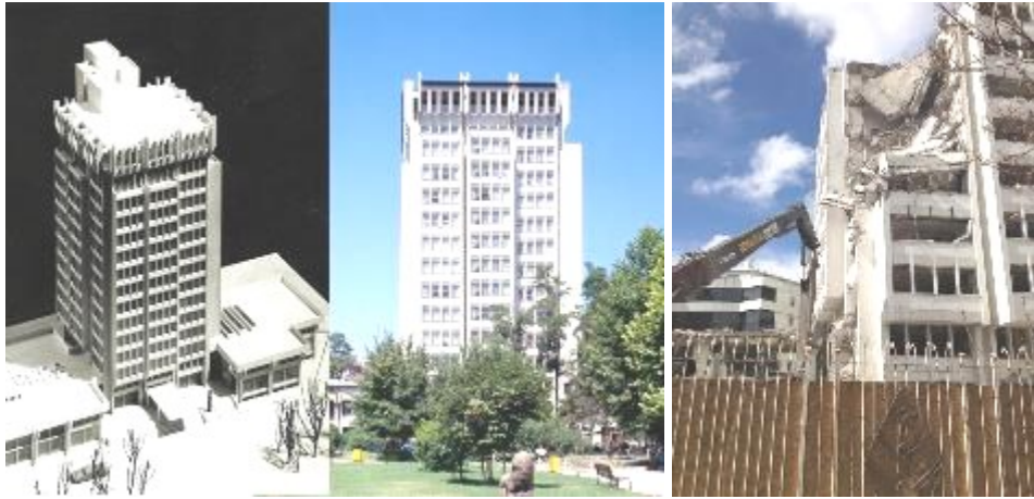
Resim 4.27. Eski Danıştay binası a. maket; b. Atatürk Bulvarından görünüşü; c. binanın yıkımı (Arkitera)
