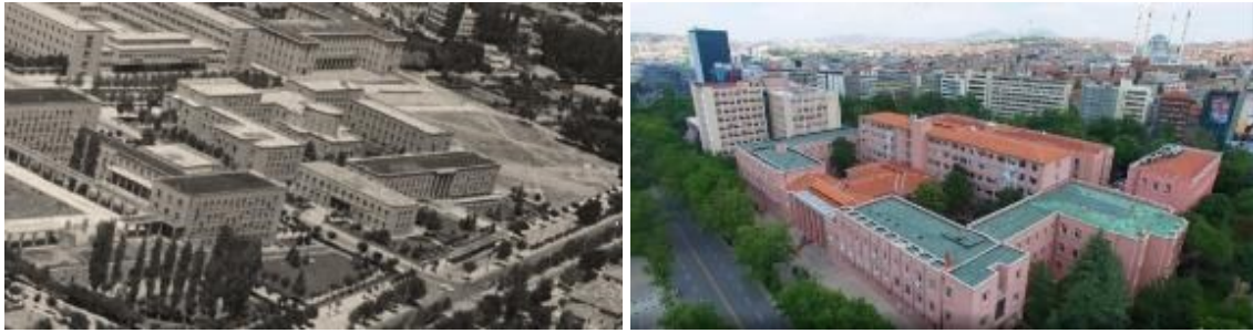
Resim 4.45. Yargıtay hizmet binası değişimi; yıkım öncesi durumu / yıkım ve ek binalarla günümüzdeki durumu [tanıtım videosundan] (Yargıtay 150.Yıl)
