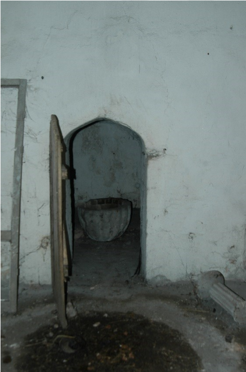
Resim 3.29 Mustafa Ağa Hamamı Z04 halvet mekânı geçiş kapısı
