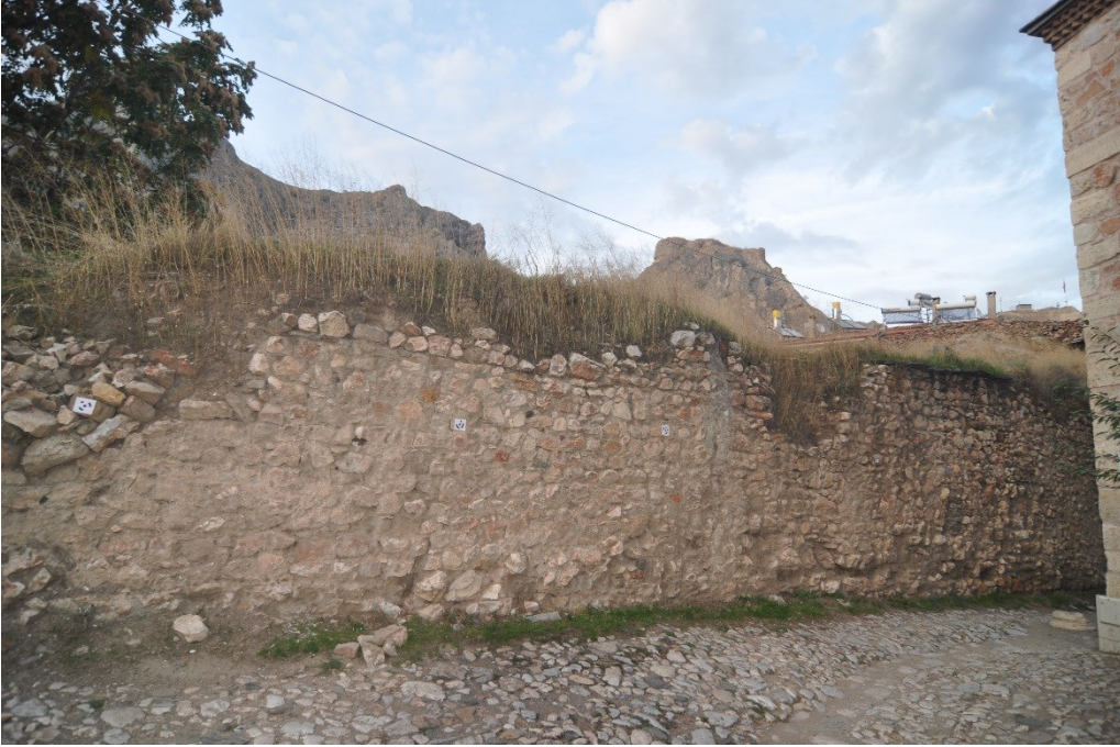
Resim 3.6. Mustafa Ağa Hamamı güney cephesi (Ekim 2016)
