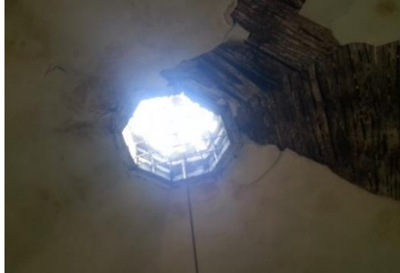
Resim 5.10. Z01 Erkekler soyunmalık mekânı prizmatik aydınlık feneri
