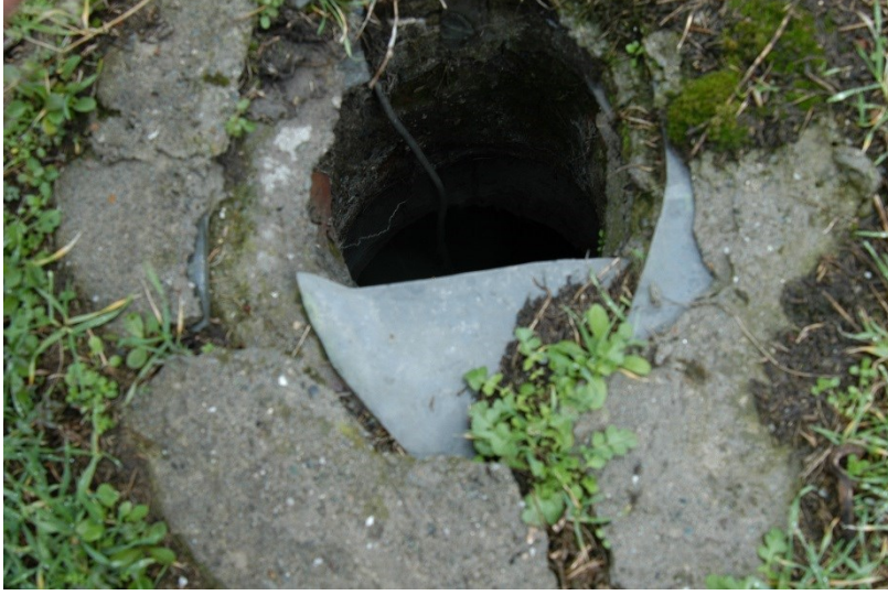
Resim 3.34 Mustafa Ağa Hamamı kubbe üzerinde ışıklık detayı (Ekim 2016)
