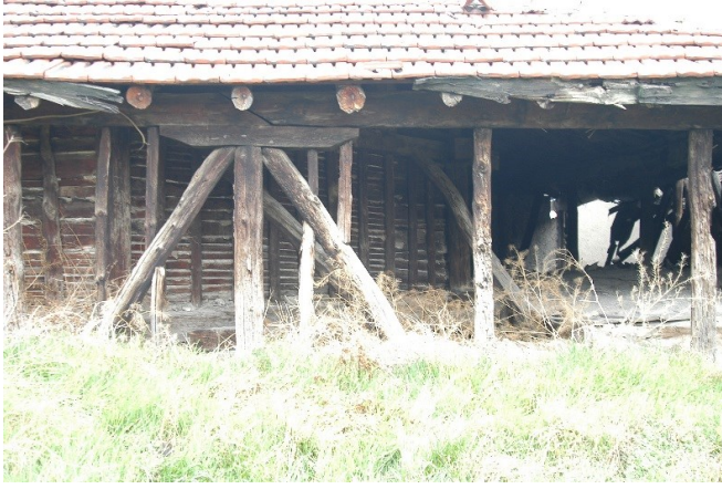
Resim 3.33 Mustafa Ağa Hamamı ahşap çatı görünüş (Ekim 2016)
