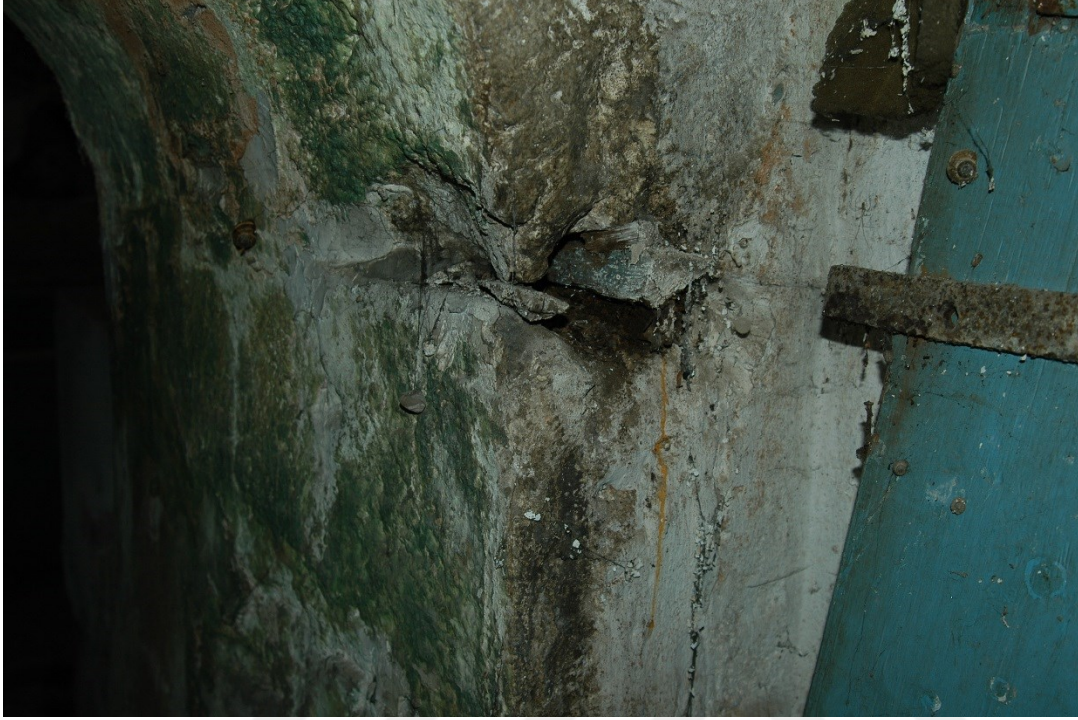
Resim 3.51. Z12 Kadınlar sıcaklık mekanı kapı detayı (Ekim 2016)
