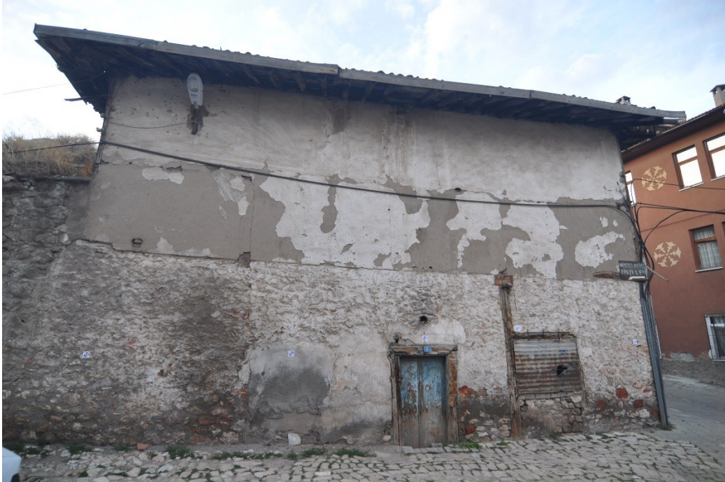
Resim 3.2. Mustafa Ağa Hamamı güney cephesi (Ekim 2016)
