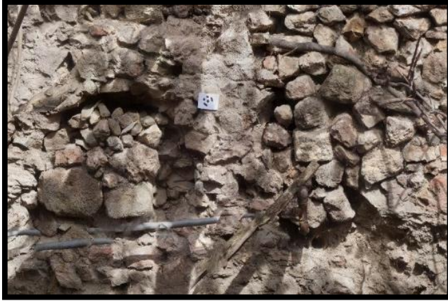
Resim 6.35. Mustafa Ağa Hamamı Batı cephesi
