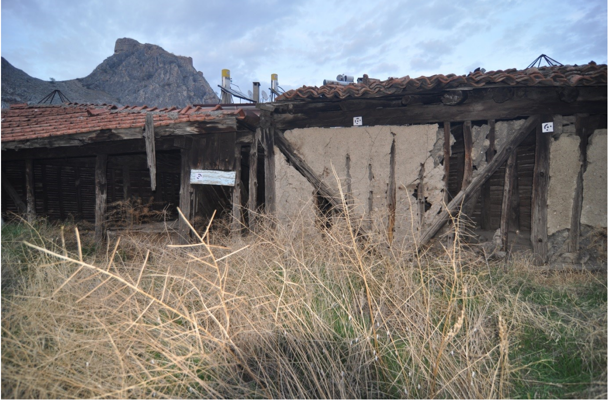
Resim 3.15. Mustafa Ağa Hamamı ahşap çatı görünüş (Ekim 2016)
