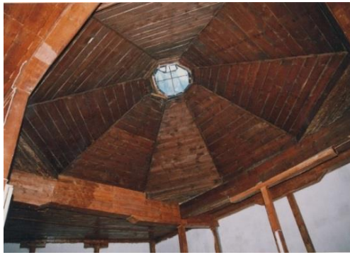
Resim 6.2. Pervane Hamamı erkekler soyunmalık bölümü çatısı [32]
