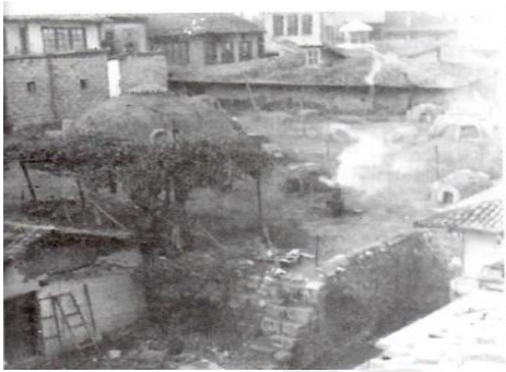
Resim 6.4. Pervane Hamamı erkekler soyunmalık bölümü çatısı [32]
