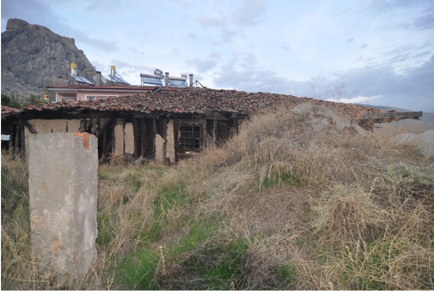
Resim 3.14. Mustafa Ağa Hamamı ahşap çatı görünüş (Ekim 2016)
