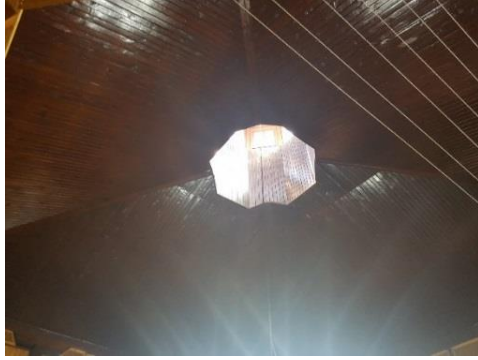
Resim 6.1. Karacabey Hamamı erkekler soyunmalık bölümü çatısı
