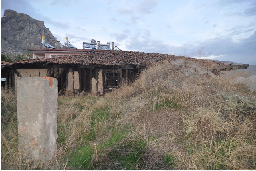
Resim 3.13. Mustafa Ağa Hamamı ahşap çatı görünüş (Ekim 2016)
