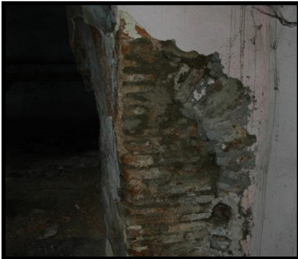
Resim 6.7. Erkekler soyunmalık bölümü Havluluk mekânına geçişte niş kemeri izi
