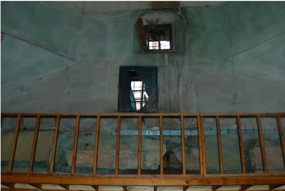
Resim 3.22. Resim Mustafa Ağa Hamamı erkekler soyunmalık mekânı D4 duvarı (Ekim 2016)
