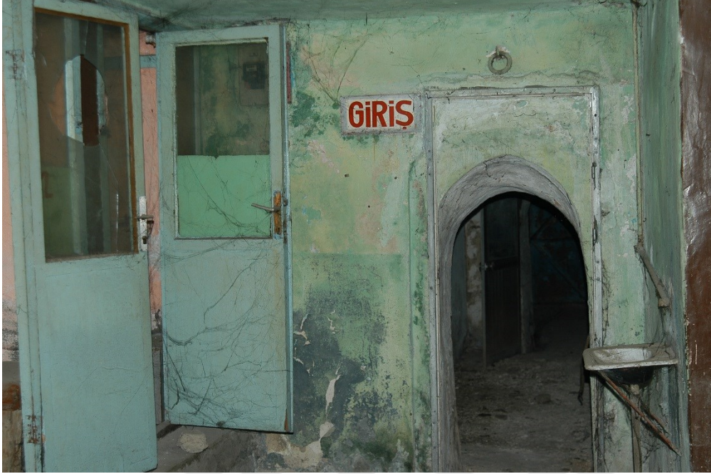
Resim 3.21. Resim Mustafa Ağa Hamamı erkekler soyunmalık mekânı Kp03 geçiş kapısı (Ekim 2016)
