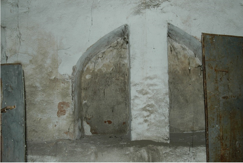
Resim 3.25 Mustafa Ağa Hamamı Z02 Helâ mekânı duvar nişi (Ekim 2016)
