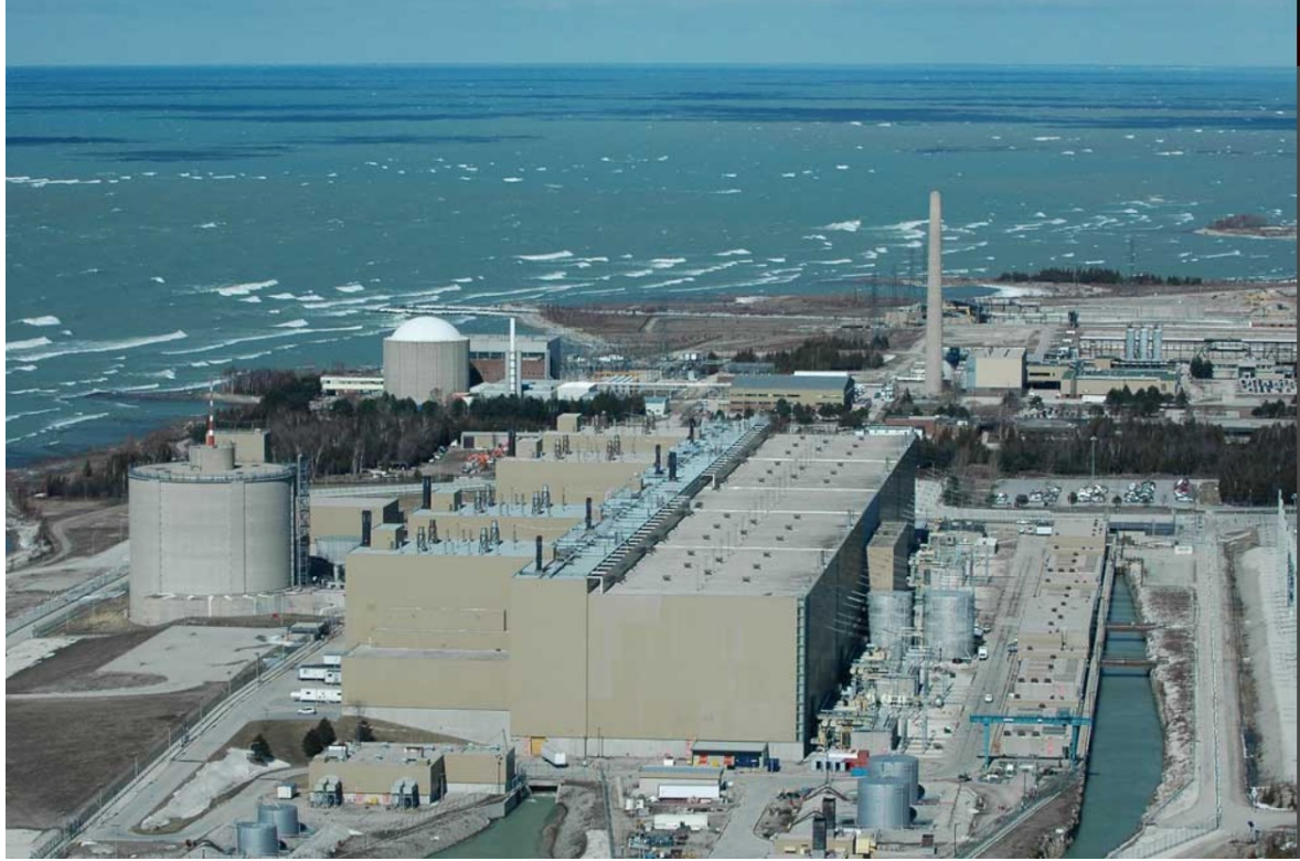
Resim 3.5. Bir PHWR santral sahası – Bruce Nükleer Santrali [27]
