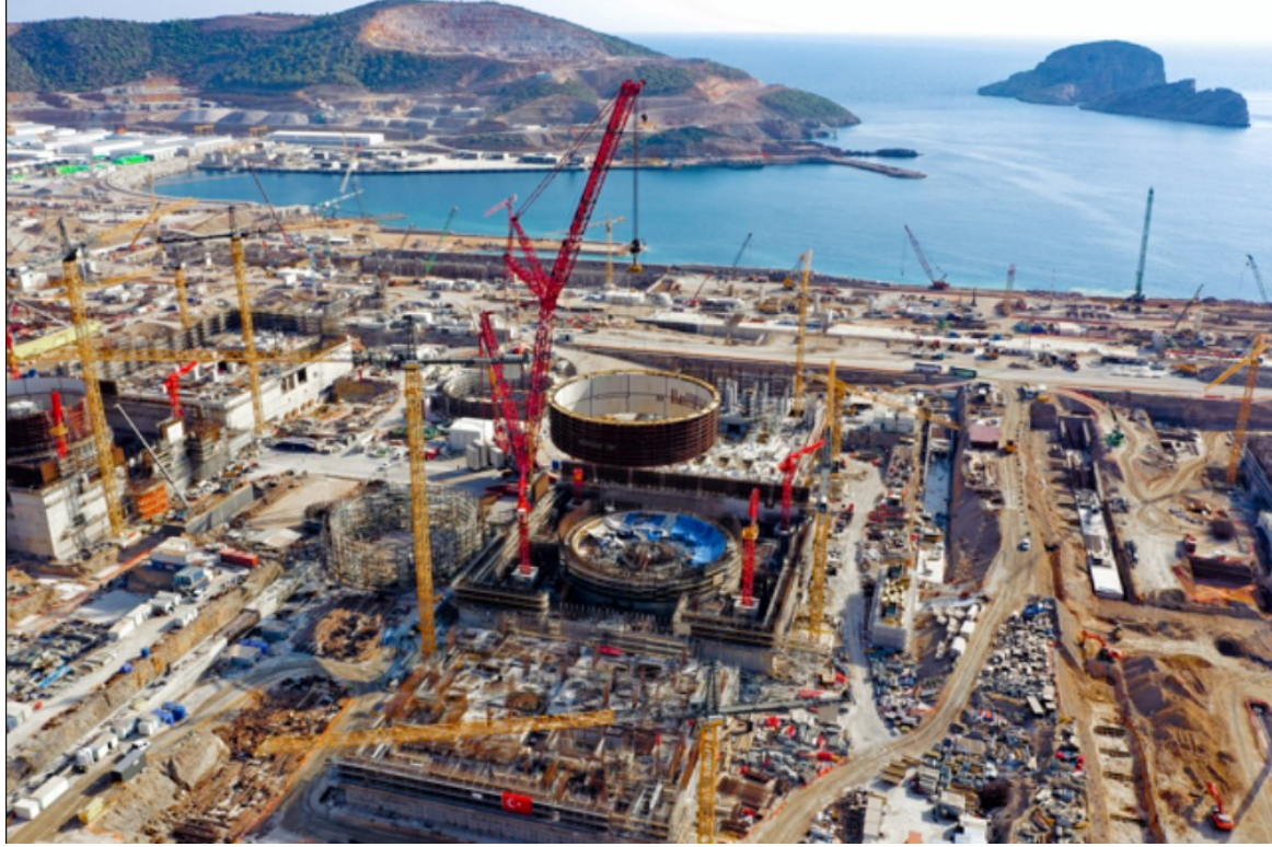
Resim 3.2. VVER-1200 Akkuyu Nükleer Güç Santrali İnşaatı [22]
