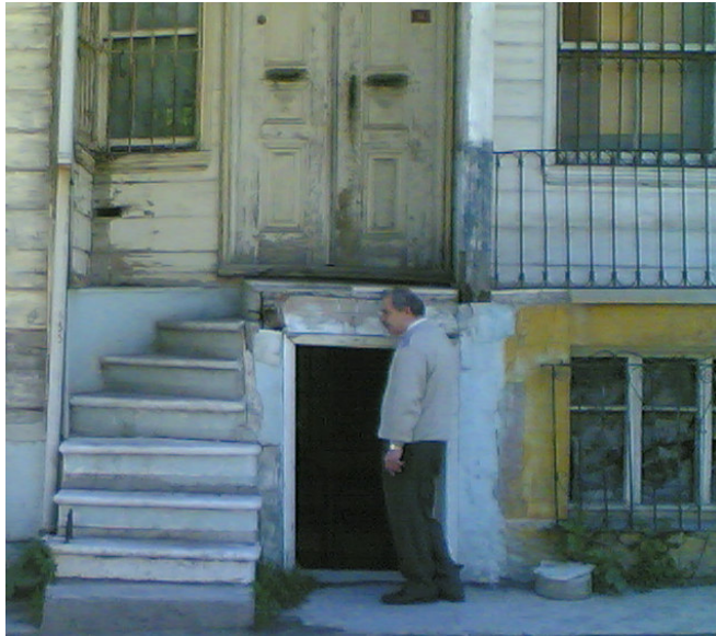
Resim 2.8. Merdivenler ve giriş nişi [Gümüş, 2006]
