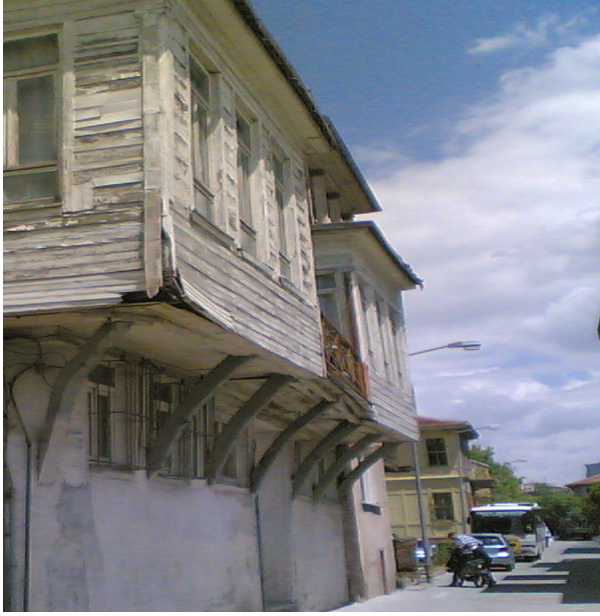
Resim 2.13. Evin iki tarafındaki cumbanın arası birleştirilerek oluşturulan balkon [Gümüş, 2006]
