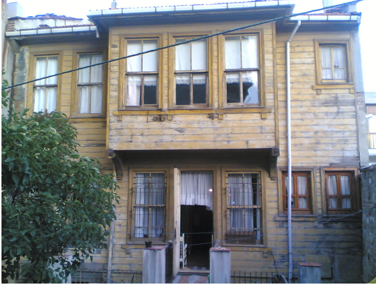
Resim 3.9. Üç numaralı ev arka cephesi [Gümüş, 2006]
