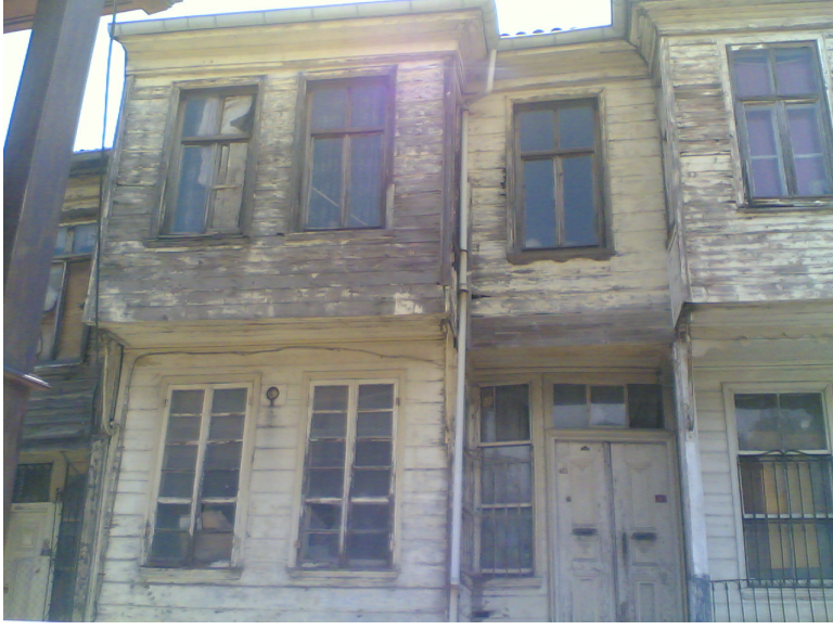
Resim 3.13. Dört numaralı evin ön cephesi [Gümüş, 2006]
