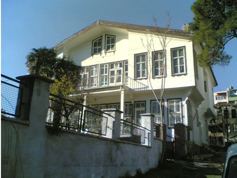
Resim 3.34. On bir numaralı evin arka cephesi [Gümüş, 2006]
