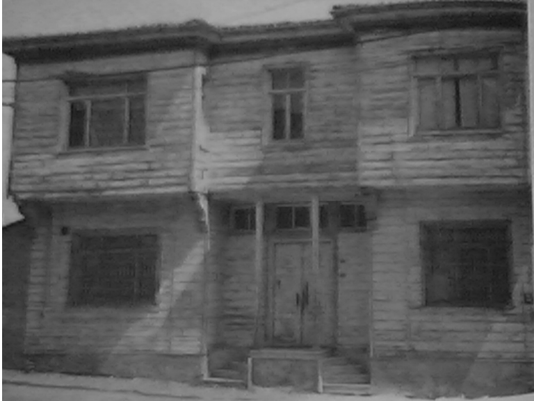
Resim 3.48. On beş numaralı evin ön cephesi [Gümüş, 2006]
