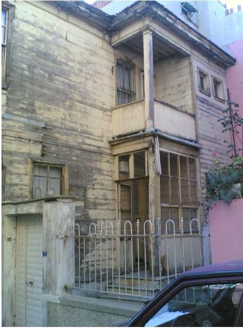
Resim 3.52. On dokuz numaralı evin ön cephesi [Gümüş, 2006]
