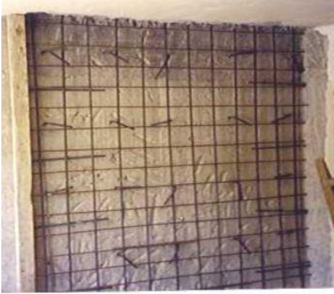
Resim 2.2. Perde kalınlığının artırılması [8]
