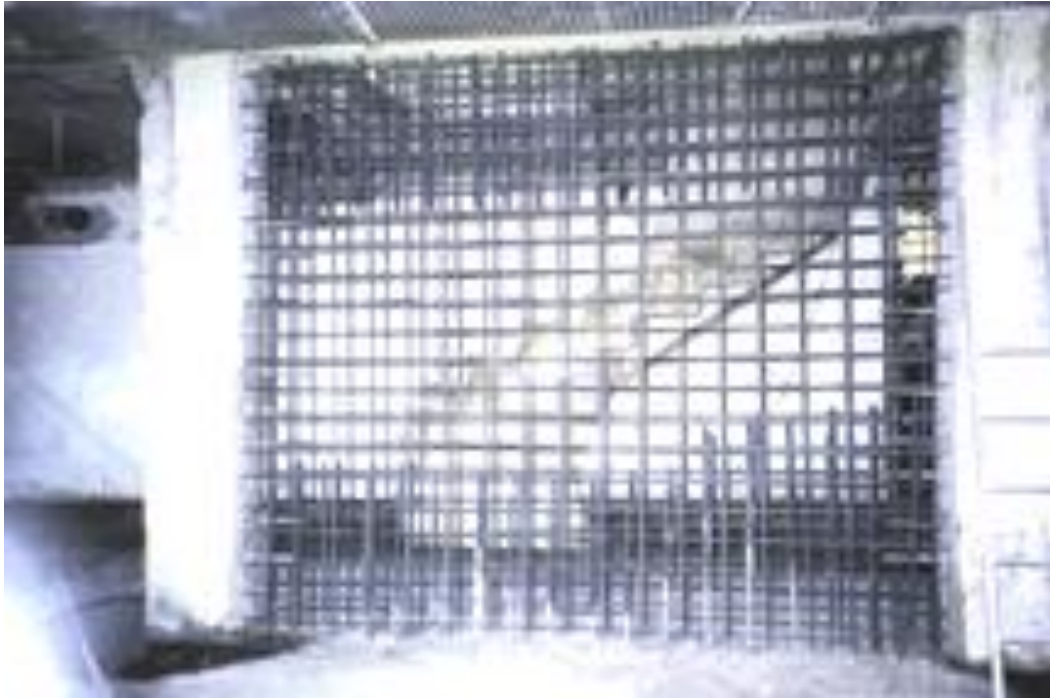
Resim 2.1. İki kolon arasına perde ilave edilmesi [8]
