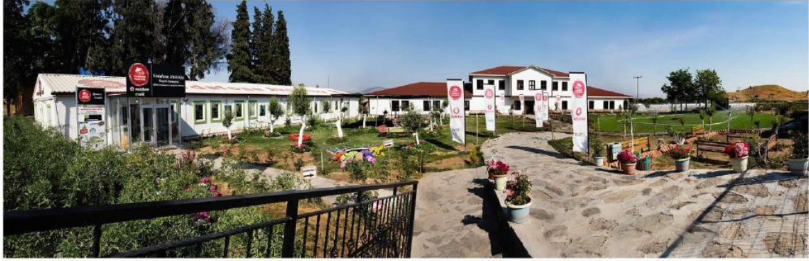
Şekil 6.2. VAK yerleşimi yönetim binası ve misafırhane (orijinal)
