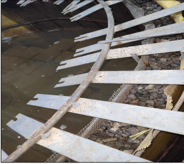
Şekil 3.6. Silindir tankta bulunan çakıl ızgara
