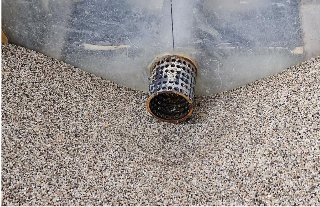
Resim 5.1. Üzerinde delikler oluşturulan bir çıkış yapısı
