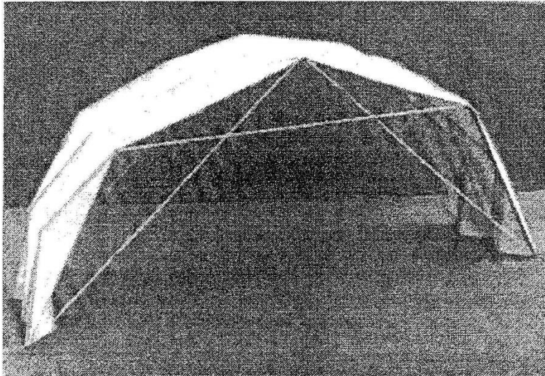
Resim 3.8. Bölme sağlamak için kullanılan gerilim kablosu [5]
