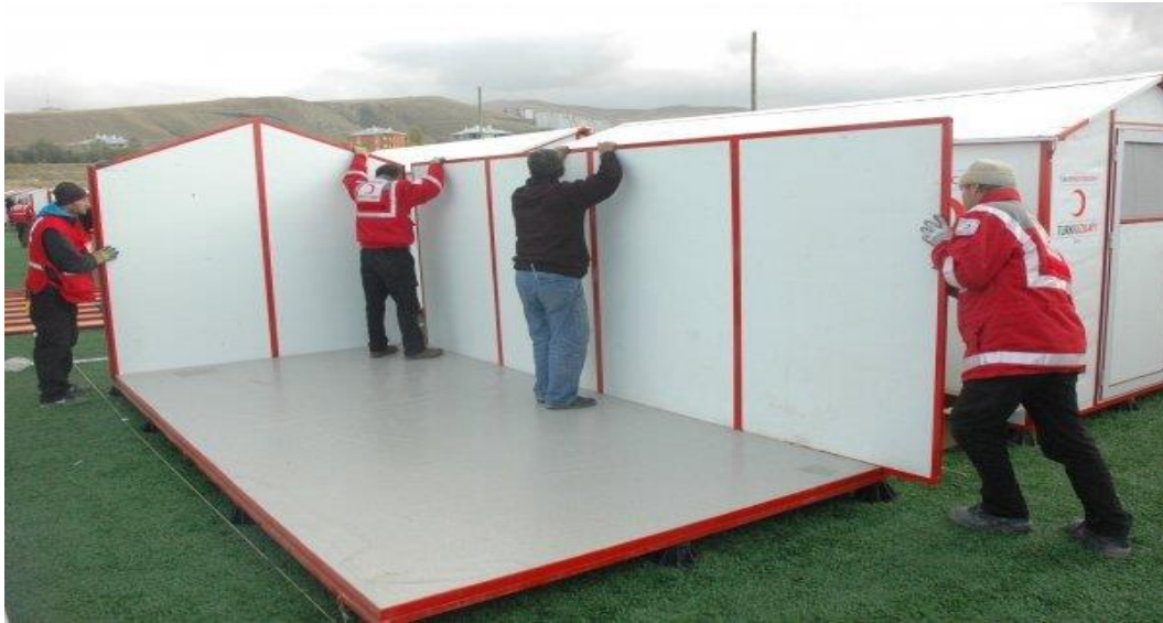
Resim 5.3. Mevlana evlerinin montajı [Haber3]
