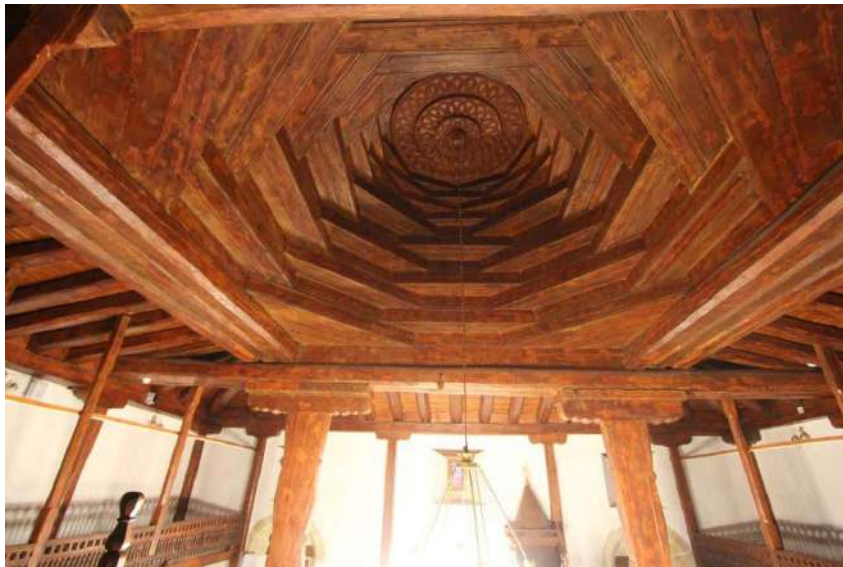
Resim 3.6. Bayburt Konursu Cami kırlangıç kubbesi (Akşam Gazetesi)
