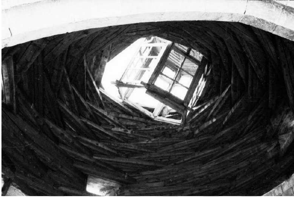
Resim 3.2. Erzurum Ulu Cami kırlangıç kubbesi (Söylemezoğlu Ailesi Arşivi, aktaran Cangül)
