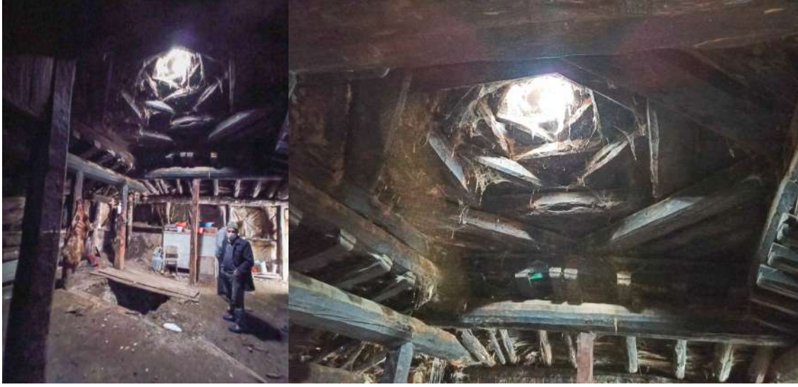
Resim 4.29. Evin iç mekânı ve kırlangıç kubbesi (Fotoğraf: Hasan Söylemez)
