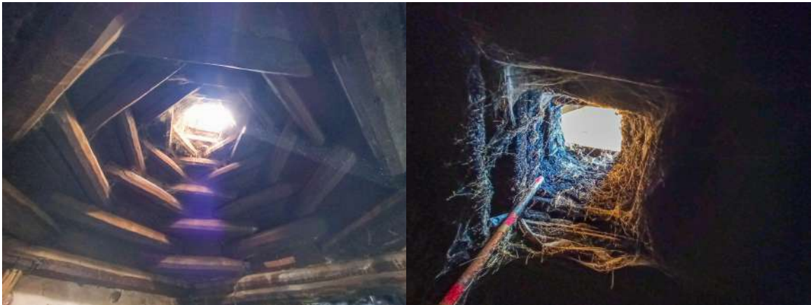
Resim 4.16. Ana mekânı örten kırlangıç kubbe ve tandırın bacası (Fotoğraf: Hasan Söylemez)
