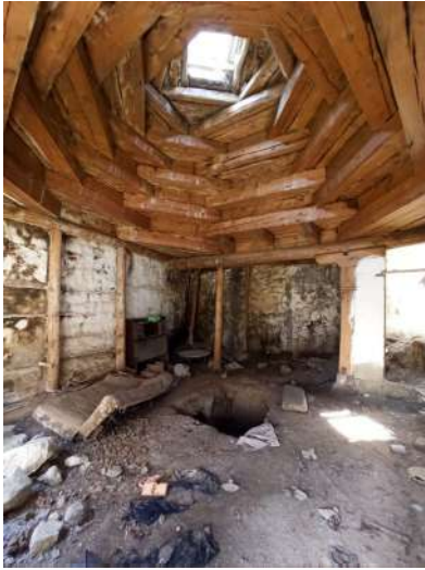
Resim 4.65. Kırılmalı kubbeli mekân ve açılmış olan patates kuyusu (Fotoğraf: Hasan Söylemez)
