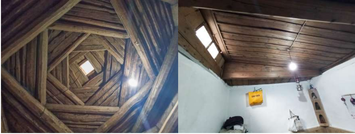
Resim 4.25. Asıl mekânı örten kırlangıç kubbe ve ek odada pasin örtüşü ile açılan tavan penceresi (Fotoğraf: Hasan Söylemez)
