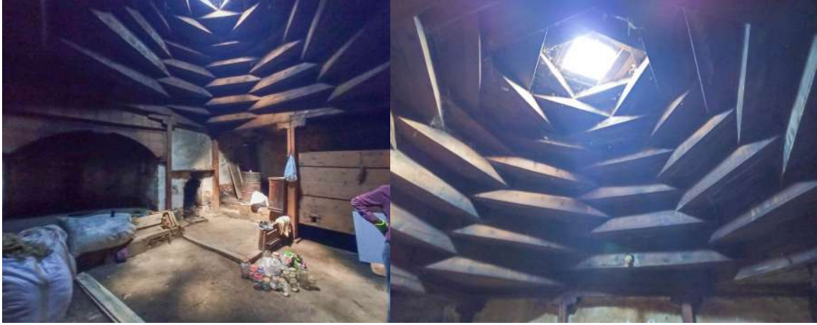
Resim 4.21. Evin iç mekânı, tandır (solda), ocak ve ambar (sağda) ve kırlangıç kubbesi (Fotoğraf: Hasan Söylemez)
