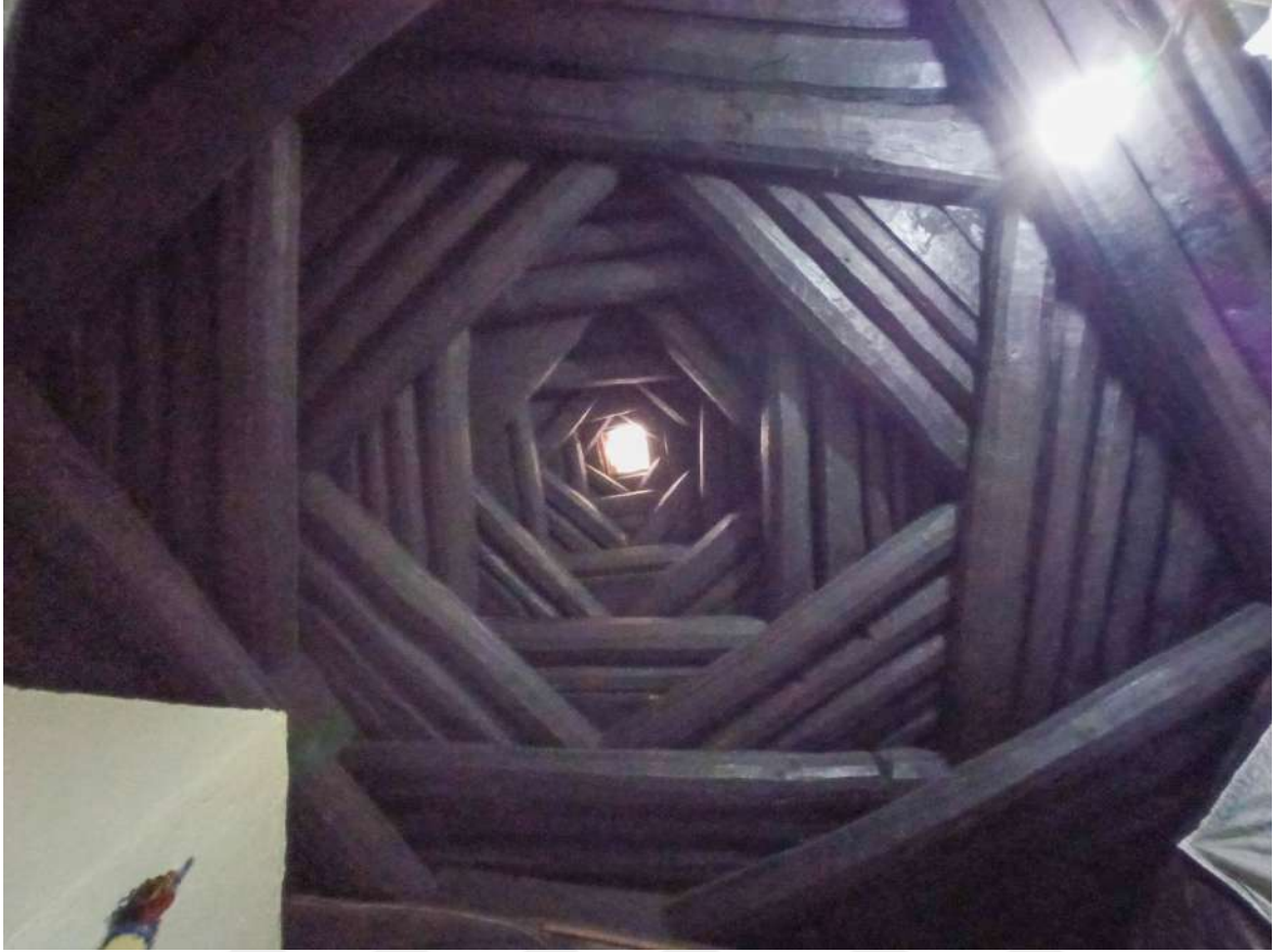
Resim 4.39. Kırlangıç kubbe (Fotoğraf: Hasan Söylemez)
