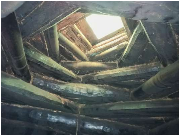
Resim 4.35. Ana mekânı örten kare kırlangıç kubbe (Fotoğraf: Hasan Söylemez)
