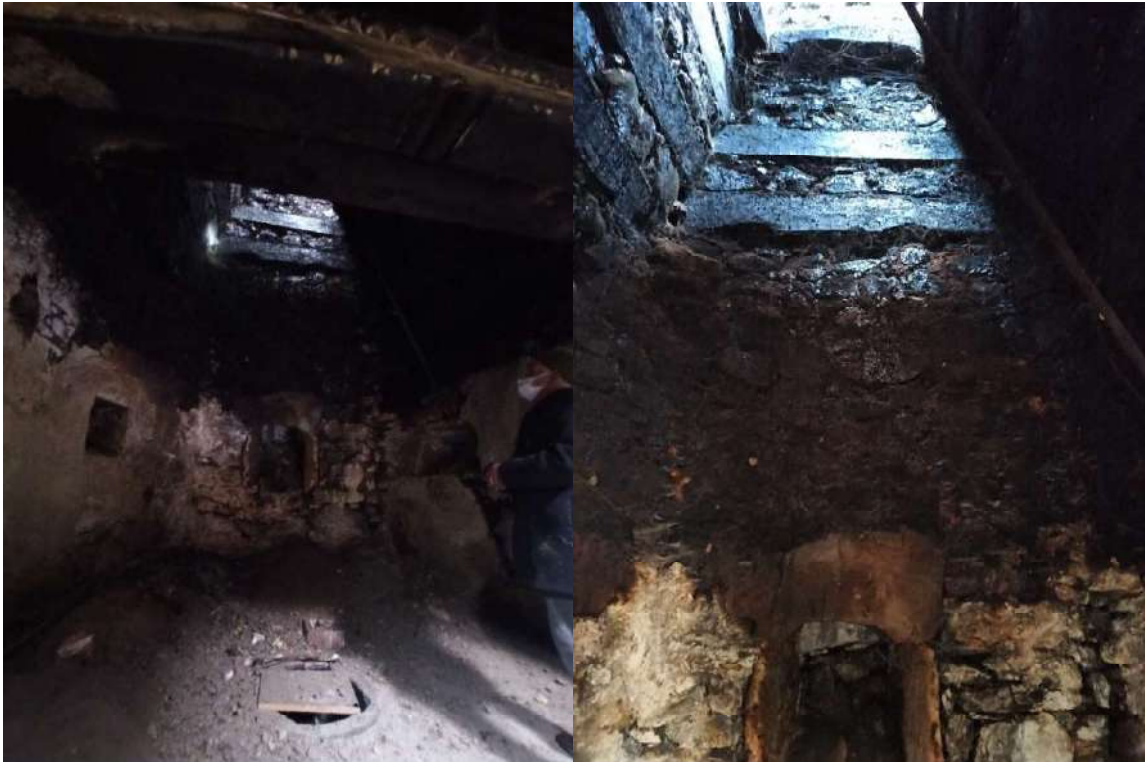
Resim 4.44. Tandır ocağı ve piramidal bacası (Fotoğraf: Hasan Söylemez)
