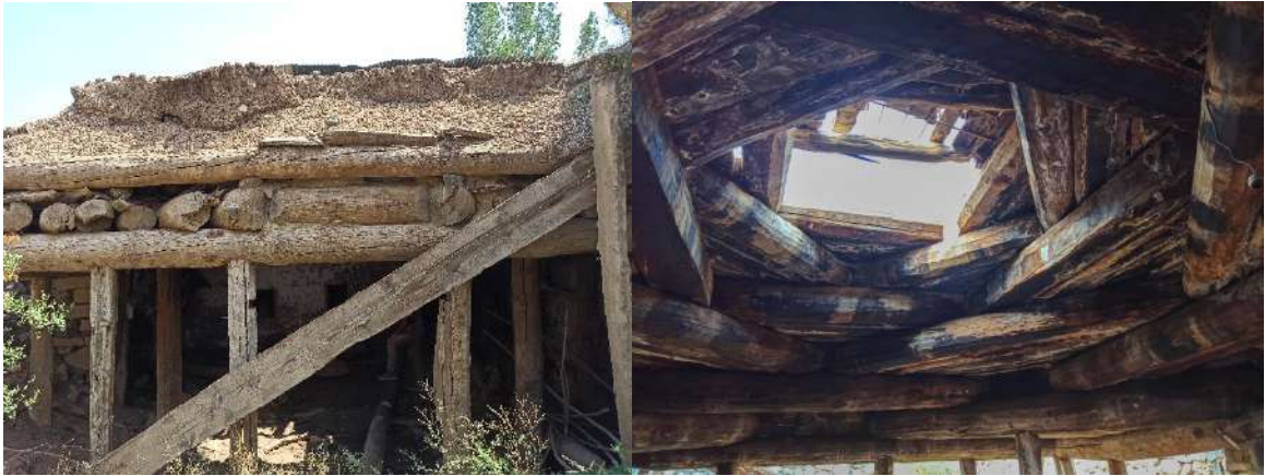
Resim 4.73. Kırlangıç kubbenin yan cepheden ve alttan görünümü (Fotoğraf: Hasan Söylemez)
