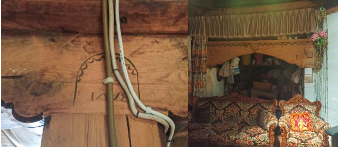
Resim 4.17. 1874 tarihli omuzluk ve iptal edilmiş olan tandır başı (Fotoğraf: Hasan Söylemez)
