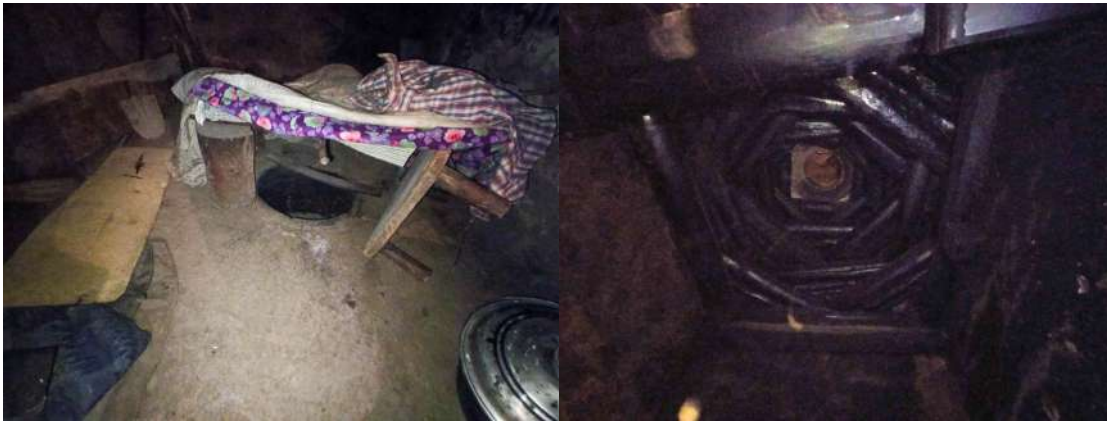
Resim 4.42. Tandır ocağı ve üzerindeki ikinci kırlangıç kubbe (Fotoğraf: Hasan Söylemez)
