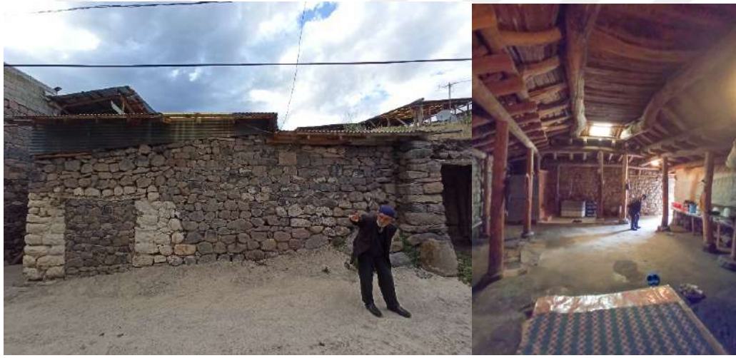
Resim 4.1. Evin girişinde bulunan ahır dış cephesi ve iç görünümü (Diğer cepheler toprağın altında veya komşu evlerle bitişik durumdadır (Fotoğraf: Hasan Söylemez)
