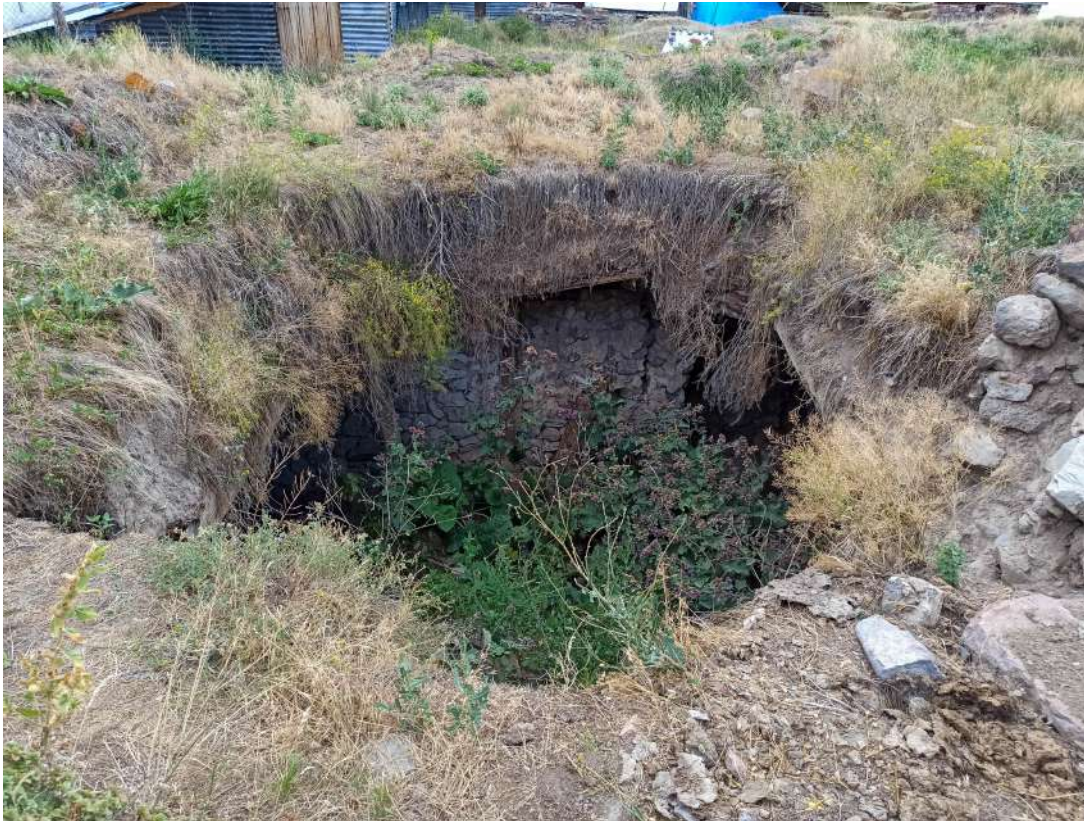
Resim 4.14. Yıkılmış kırılmaç kubbenin ilk sırası (Fotoğraf: Hasan Söylemez)
