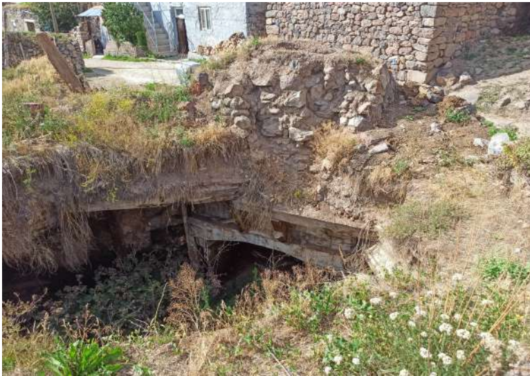
Resim 4.12. Yıkılmış kırlangıç kubbenin ilk sırası ve tandır bacası (Fotoğraf: Hasan Söylemez)
