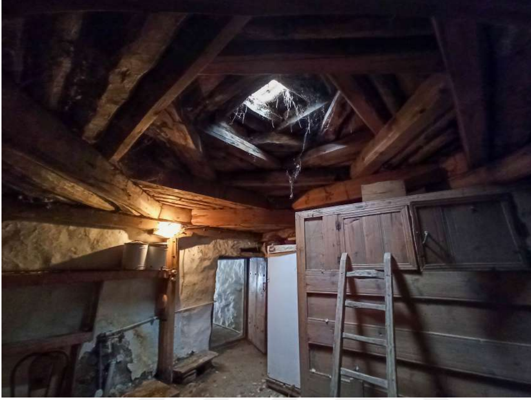
Resim 4.53. Ana mekânı örten kırlangıç kubbe (Fotoğraf: Hasan Söylemez)
