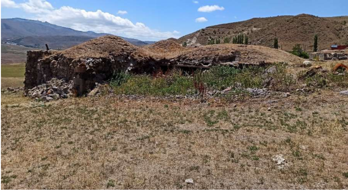
Resim 4.55. 1 ve 2 numaralı evlerin dışarıdan görünümü (soldaki iki yükselti kırlangıç kubbe, sağdaki yükselti ahır) (Fotoğraf: Hasan Söylemez)
