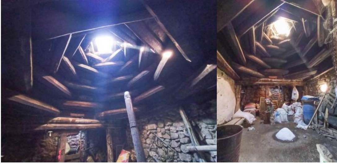
Resim 4.15. Ana mekân ve üzerindeki kırlangıç kubbe (Fotoğraf: Hasan Söylemez)
