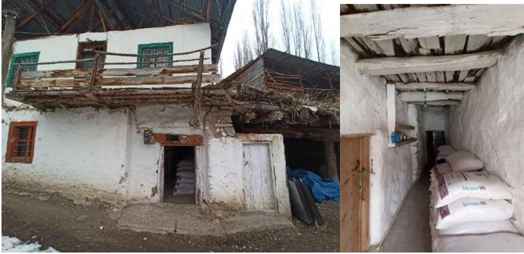
Resim 4.50. Giriş cephesi ve ana mekâna ulaşan koridor (Fotoğraf: Hasan Söylemez)
