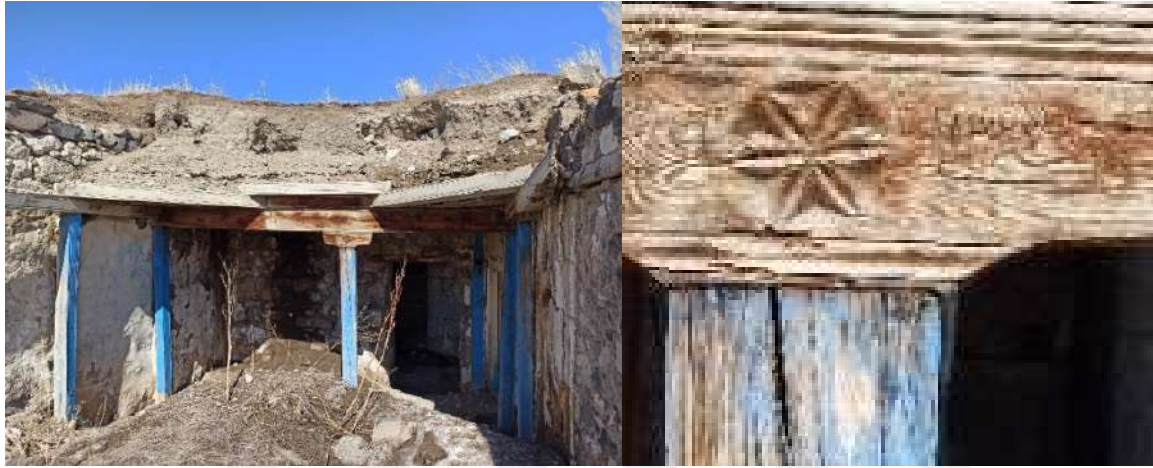
Resim 4.66. 1322 tarihli evde yıkılmış olan kırlangıç kubbe (Fotoğraf: Hasan Söylemez)
