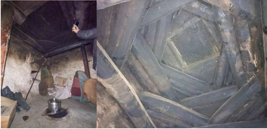
Resim 4.36. Tandır ocağı ve üzerindeki diğer kırlangıç örtü (Fotoğraf: Hasan Söylemez)
