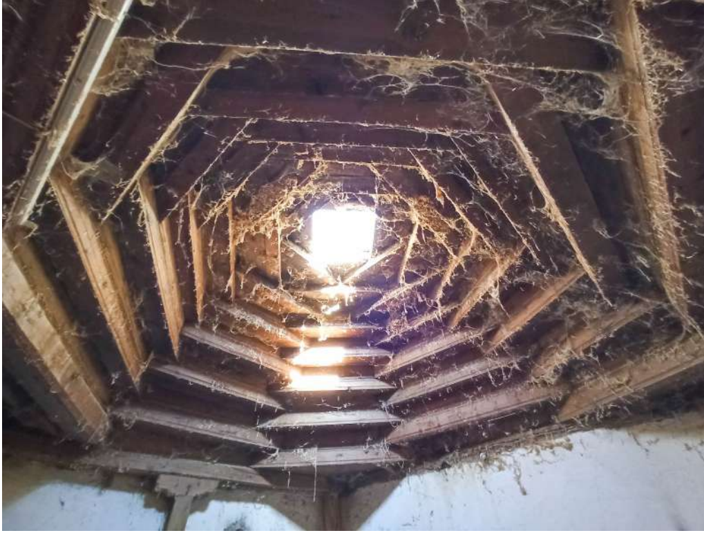
Resim 4.59. Ana mekânı örten kırlangıç kubbe (Fotoğraf: Hasan Söylemez)
