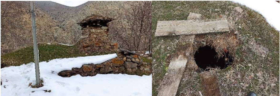
Resim 4.28. Evin arka cephesi, tandır bacası ve tüteklik (Fotoğraf: Hasan Söylemez)
