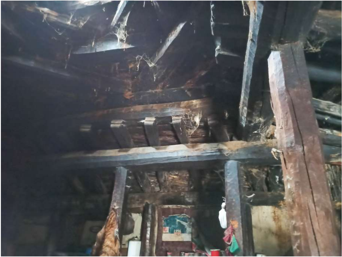
Resim 4.30. Kırlangıç kubbenin oturtulması için açıklığı kareye dönüştüren ahşap kirişlemeler (Fotoğraf: Hasan Söylemez)
