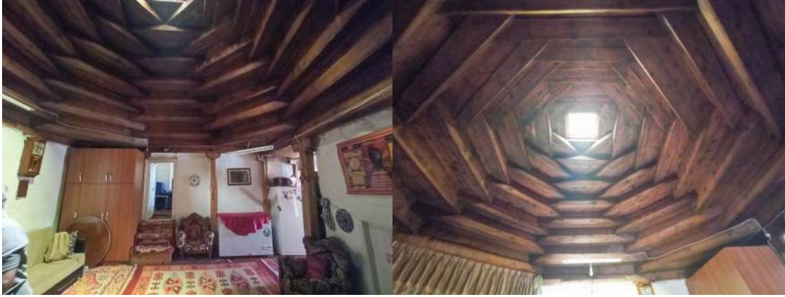
Resim 4.18. Tandır başından evin iç görünümü ve kılıngıç kubbe (Fotoğraf: Hasan Söylemez)
