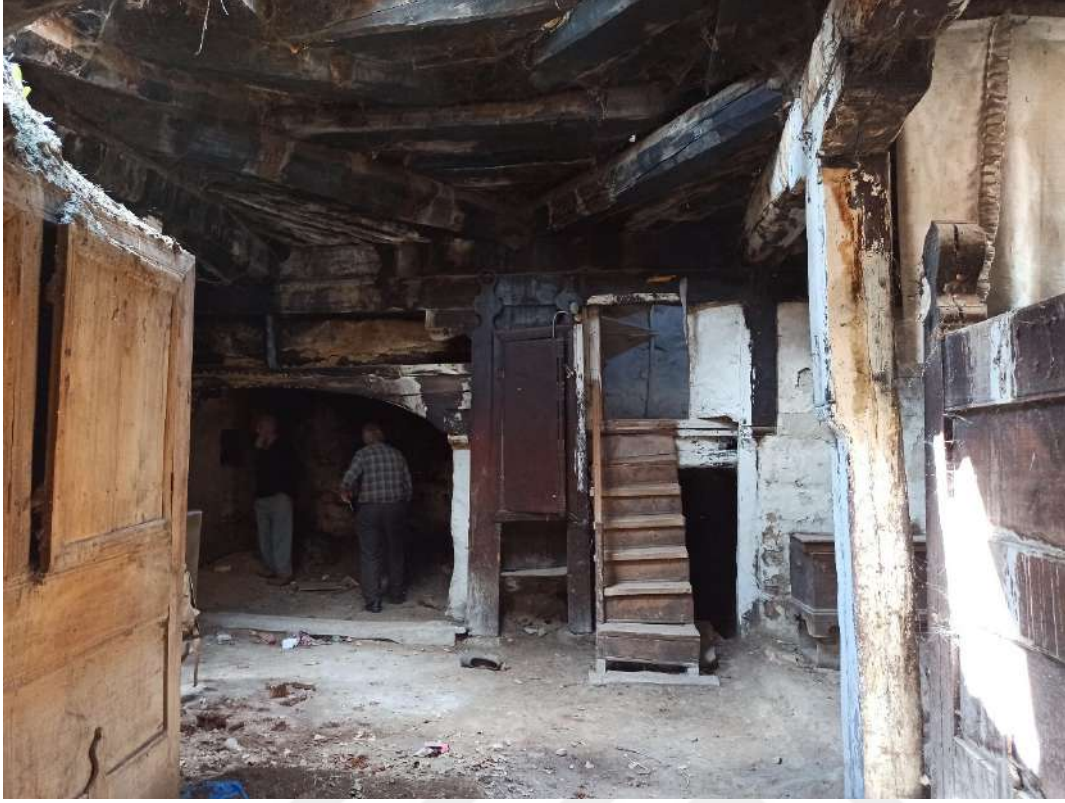
Resim 4.47. Tandır ocağı (solda), süslemeli dolap kapağı (ortada), yerden yükseltilmiş olan ek odanın girişi (sağda), merdiven arkasında toprağa gömülmüş olan diğer odanın kapısı (Fotoğraf: Hasan Söylemez)
