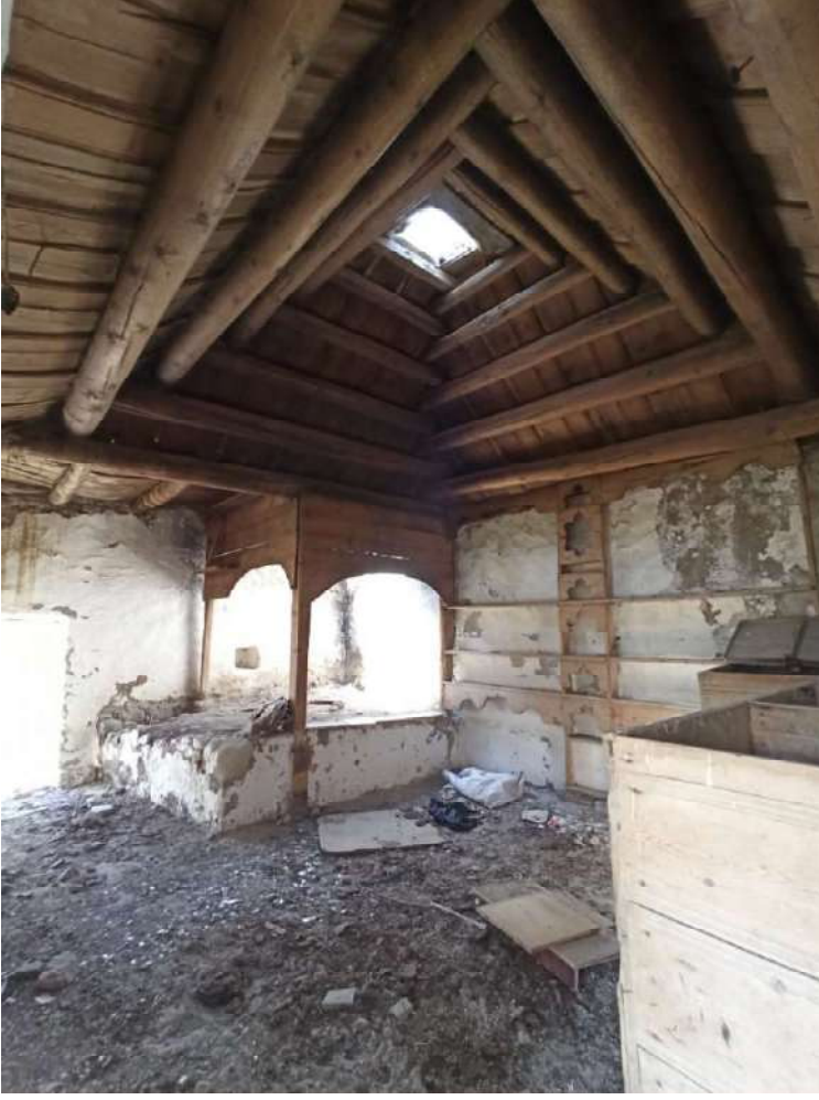
Resim 4.68. Kırlangıç kubbeye benzetilerek yapılan bir örtü (Fotoğraf: Hasan Söylemez)
