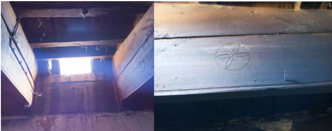
Resim 4.23. Pasın örtüşü tekniğiyle açılan tavan penceresi ve kiriş üzerinde bulunan çiçek motifi (Fotoğraf: Hasan Söylemez)
