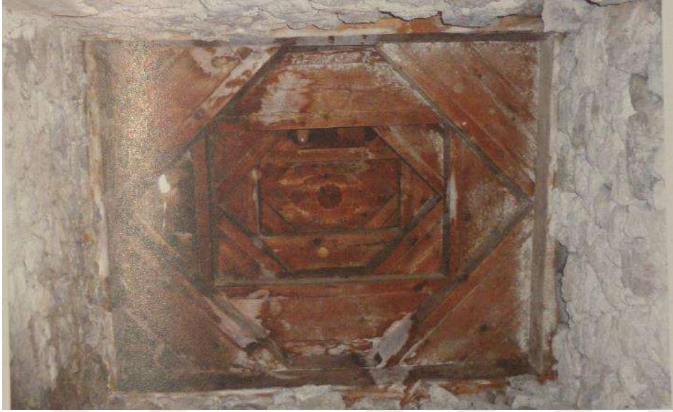
Şekil 2.9. Harcam Köyü Camii giriş üzerindeki kılranıç kubbe, Adigeni Bölgesi (Gümüş ve diğlerleri, 2019)
