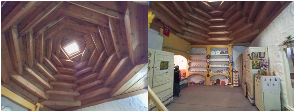
Resim 4.2. Ana mekânı örten kırlangıç kubbe ve girişten evin iç mekân görünümü (Fotoğraf: Hasan Söylemez)
