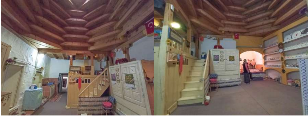
Resim 4.4. Kırılmaç kubbe ile örtülen ana mekân (Fotoğraf: Hasan Söylemez)
