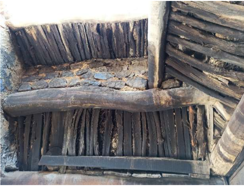
Resim 4.69. Tandırın üstünü örten baca detayı (Fotoğraf: Hasan Söylemez)
