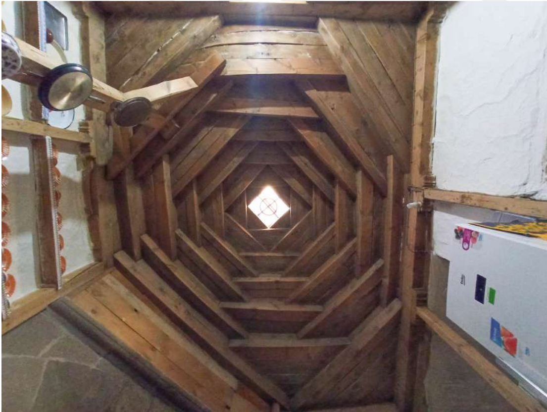
Resim 4.10. Ana mekânı örten kırlangıç kubbe (Fotoğraf: Hasan Söylemez)
