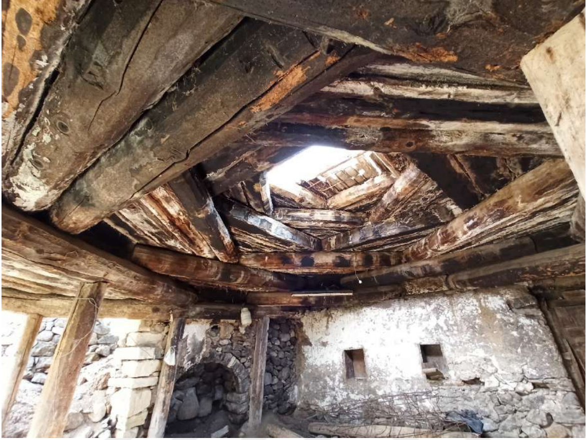
Resim 4.72. İç mekânda kırlangıç kubbe (Fotoğraf: Hasan Söylemez)
