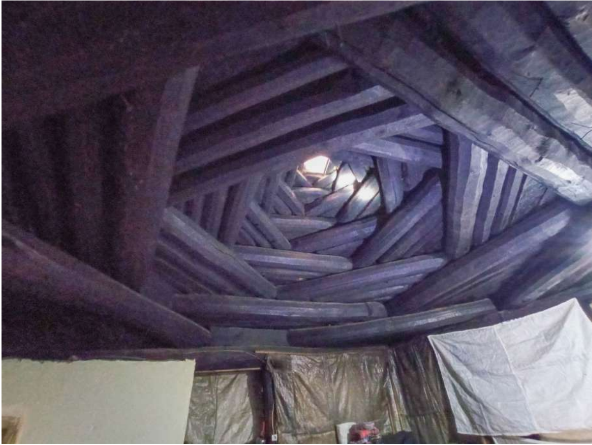
Resim 4.38. Kırlangıç kubbe (Fotoğraf: Hasan Söylemez)
