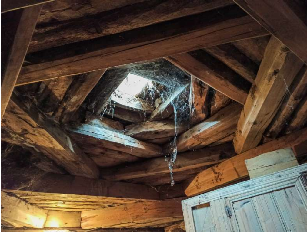
Resim 4.54. Ana mekânı örten kırlangıç kubbe (Fotoğraf: Hasan Söylemez)
