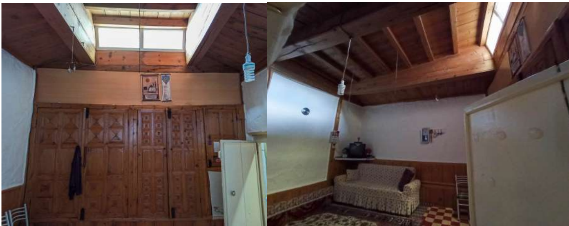
Resim 4.5. Diğer odalarda bulunan pasin örtüşü ile açılmış tavan pencereleri (Fotoğraf: Hasan Söylemez)
