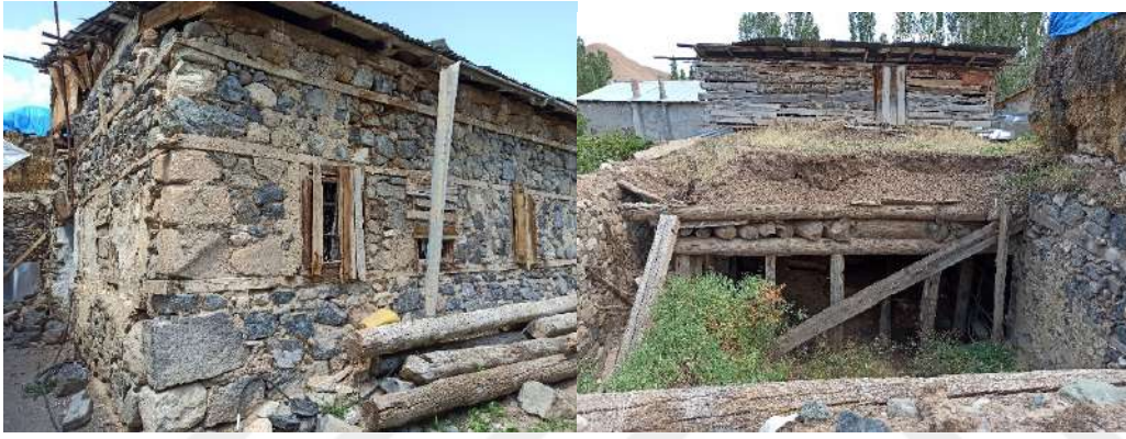
Resim 4.70. Yapının ön ve arka cepheden görünümü (Fotoğraf: Hasan Söylemez)
