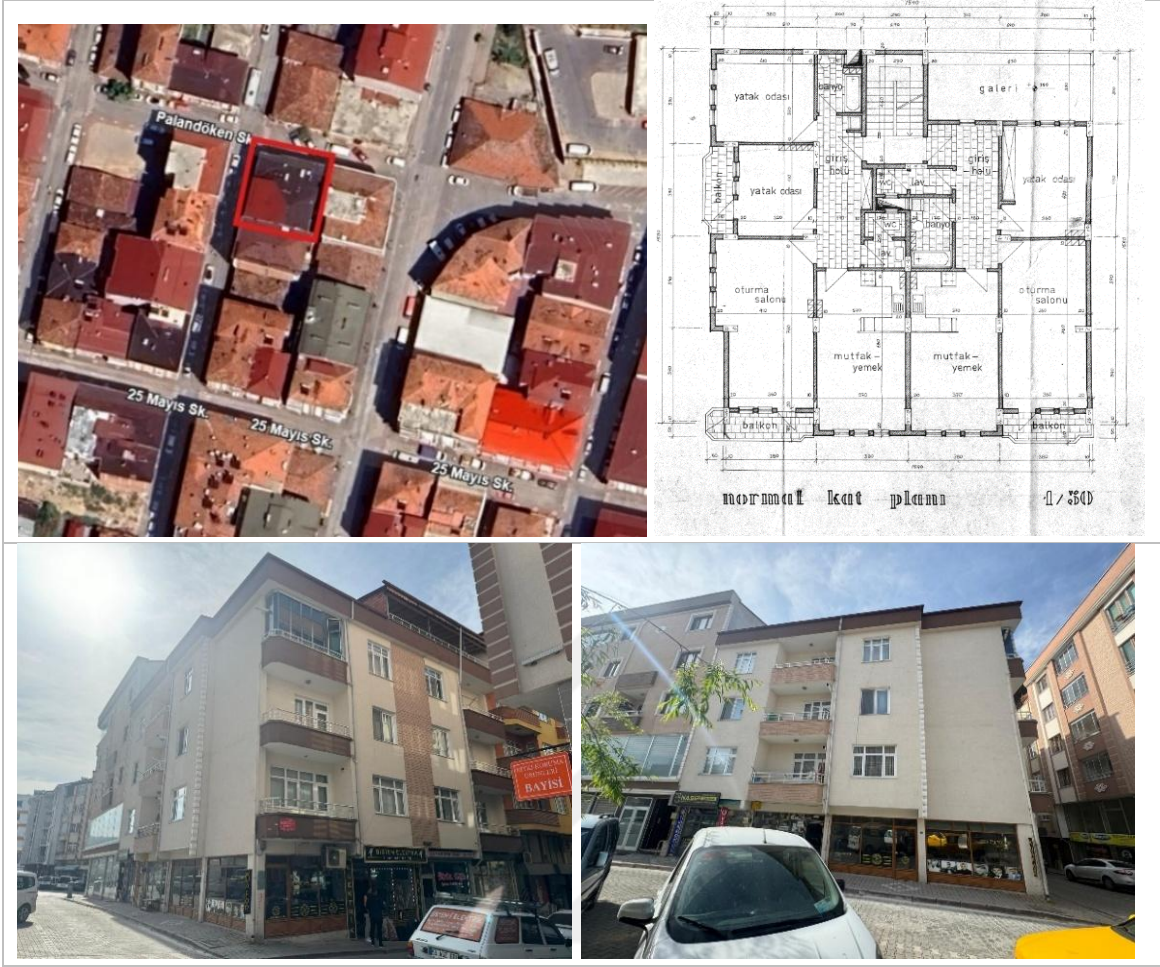
Resim 4.1. Seçilen konut binası (Coşkun, 2024)
