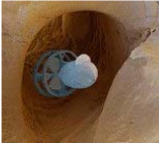
Resim 3.36. HPÜ teknolojisi ile inşa edilmiş mikro denizaltı [6, 26]
