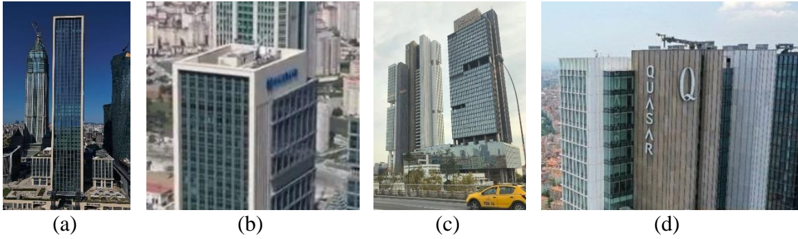
Resim 5.9. 40-19; Tabelanın cepheyle entegre olması ve yakın çevresinde yüksek yapı varlığı kriterlerini barındıran çözümler; (a), (b) Halkbank Merkez Kulesi (URL-97), (c), (d) Quasar İstanbul (URL-98)
