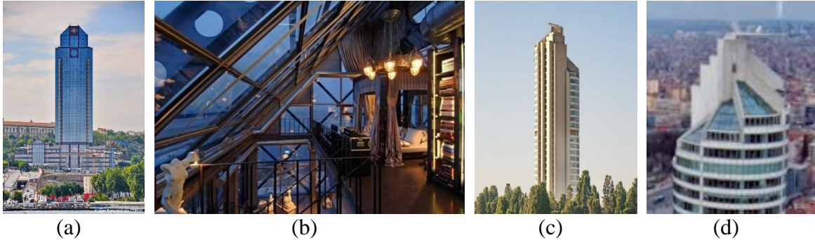
Resim 5.8. 13-2; Üst bitişte kapalı/ tanımlı hacim varlığı ve üst bitişte özel mülkiyet varlığı kriterlerini barındıran çözümler; (a), (b) Süzer Plaza (URL-95), (c), (d) Şişli Elite (URL-96)
