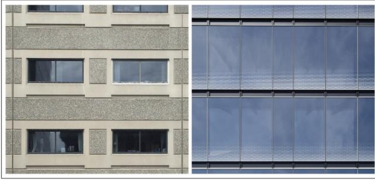
Resim 2.2. Postane binası cephe yenileme görseli (URL6)
