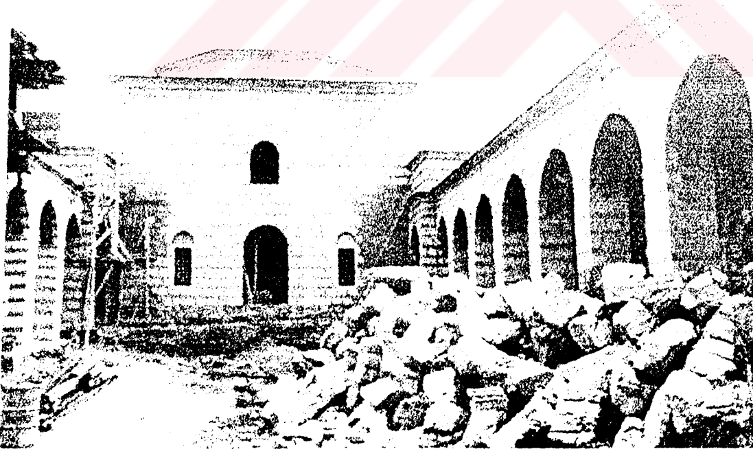
Resim 4: Yıldırım İmaret'i İç Avludan Bir Görünüm (Onarım Halinde İken)
