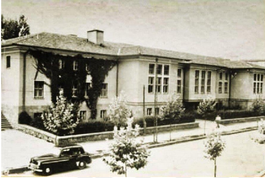
Resim 6.1. Kumrular Sokak'ta bulunan Millî Kütüphane binası (Anonim, 2007)
