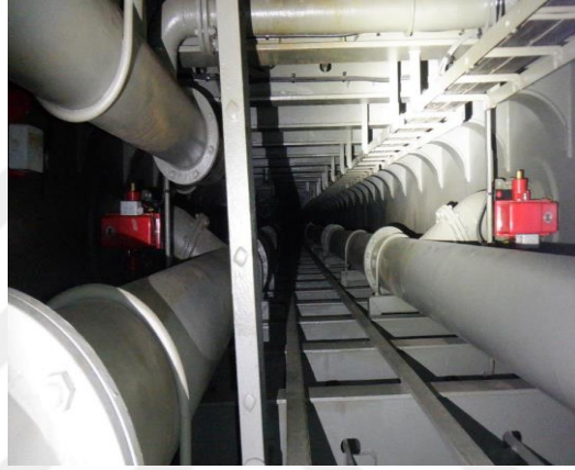
Resim 2.2. Boru tüneli
