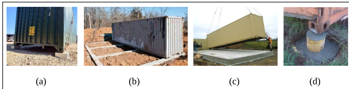
Resim 2.5. Konteyner birimlerin zemine montajında kullanılan temel tipleri: tekil temel (a) (Url-18), sürekli temel (b) (Url-19), radye temel (c) (Url-19), kazık temel (d) (Url-20)
