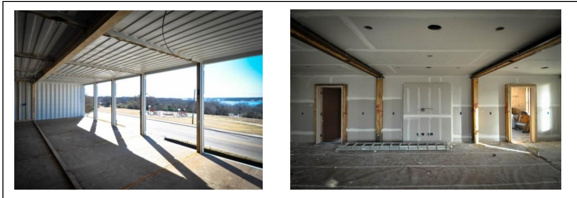
Resim 2.4. Geniş mekanlar oluşturmak amaçlı, konteyner yan yüzeylerine zıt yön doğrultusunda alınabilecek müdahale önlemi (Url-17)
