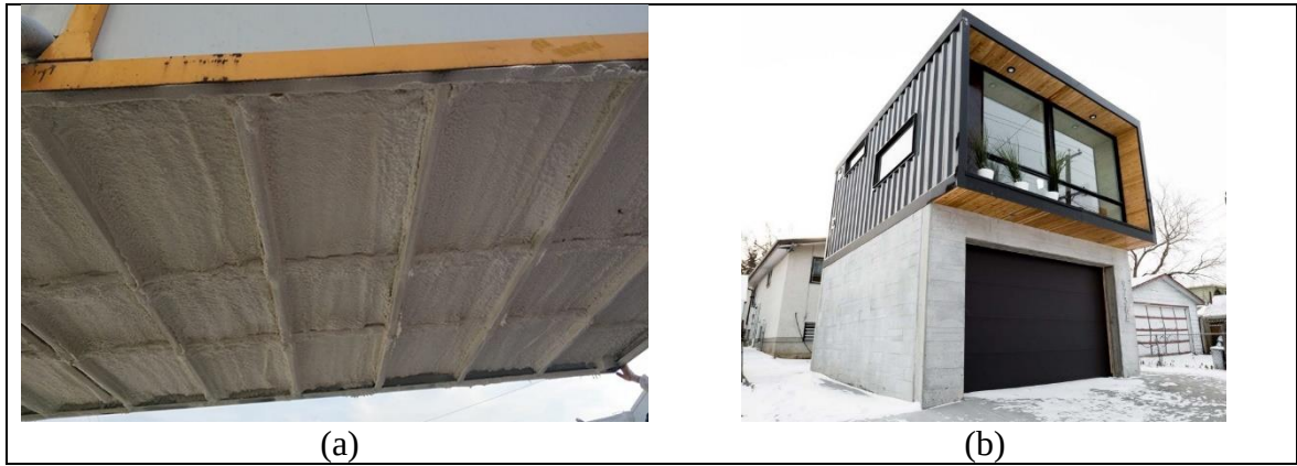
Resim 2.20. Konteyner birimlerdeki merkezi drenaj borusunun konumlandırılmasında alınan önlemler: merkezi drenaj borusunun bulunduğu konteyner döşemesinin poliüretan spray köpük ile yalıtılması (a) (Url-37), çok katlı konteyner yapılarda zemin katın betonarme iskelet sistem ile yapılması (b) (Url-38)
