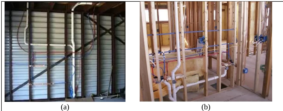
Resim 2.19. Konteyner birimlerdeki sıhhi tesisat hatlarının uygulanması (Heltzen, 2021): konteyner ana kabuğundaki sıhhi tesisat hatları (a), bölme duvarlardaki sıhhi tesisat hatları (b)
