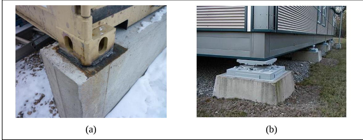
Resim 2.6. Konteyner birimlerin zemine montajında alınan ek önlemler: çelik plakalarla kaynaklanması (a) (Url-21), sismik izolatörlerin kullanılması (b) (Url-22)
