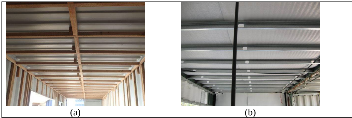
Resim 2.18. Konteyner birimlerde karkas çerçeve oluşturulması (Stetson, 2023): ahşap karkas çerçeve (a), metal karkas çerçeve (b)
