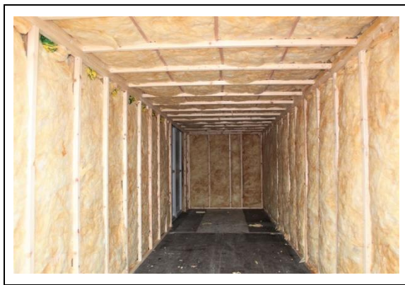
Resim 2.12. Konteyner birimlerde sert mineral yün yalıtım uygulaması (Url-33)
