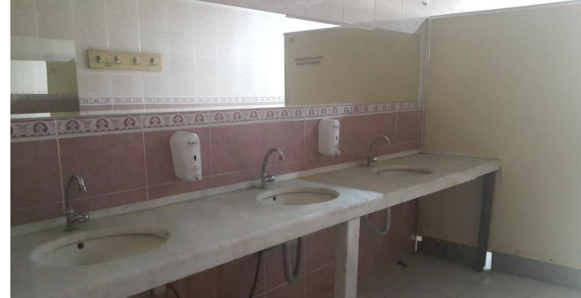
Şekil 76. Resim-iş Eğitimi AD binası tuvaleti
