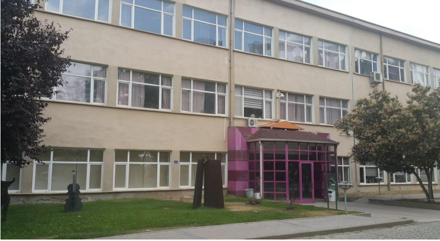
Şekil 73. Resim-iş Eğitimi AD binası
