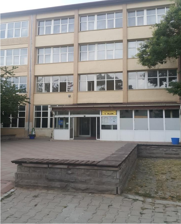
Şekil 49. C blok binası
