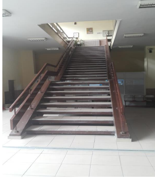
Şekil 52. C blok binası merdivenler
