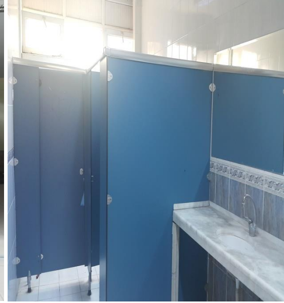
Şekil 53. C blok binası tuvalet
