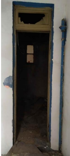
Resim 5.17. Tamamlanan iç kapı
