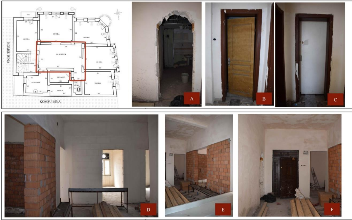
Resim 4.17. 111 nolu koridora ait görseller: (A)110 nolu mutfığa geçiş açıklığı, (B)107 nolu weye geçiş kapısı, (C)108 nolu banyoya geçiş kapısı, (D)D1-D6 duvarları, (E)D1-D2 duvarları, (F)D2 duvarı
