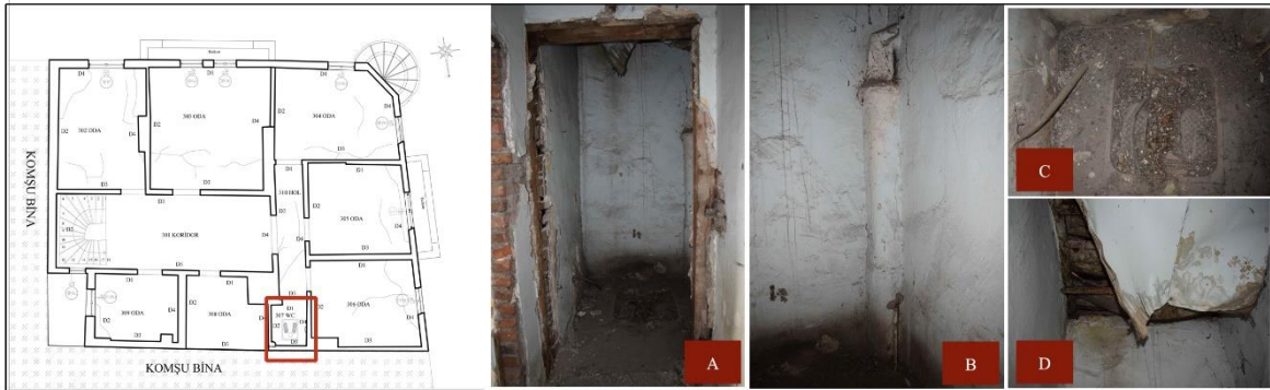
Resim 4.35. 307 nolu WC'ye ait görseller: (A)Mahal görünüm, (B)D2-D3 duvarı kesişim, (C)Mahal zemini, (D)Mahal tavanı
