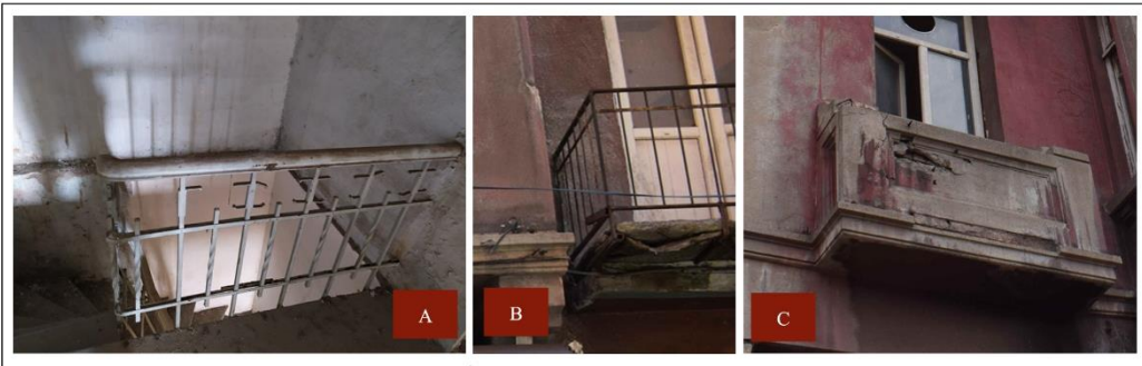
Resim 4.47. Korkuluk görselleri: (A)Merdiven, (B)102 nolu oda balkon korkuluğu, (C)Özgün balkon duvarları
