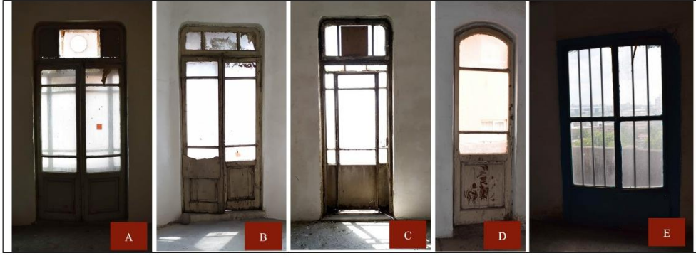
Resim 4.42. Kapı görselleri: (A)TİP-K1, (B) TİP-K2, (C) TİP-K3, (D) TİP-K4, (E)K-11
