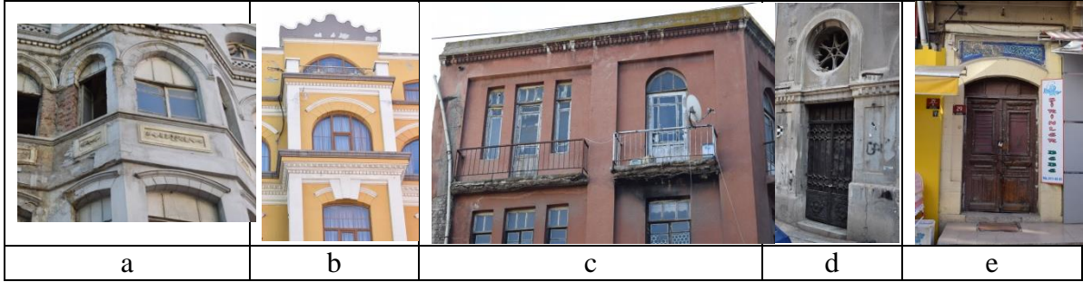
Resim 5.2. Pencere-Kapı Örnekleri (a)(b)(c)(d)(e)
