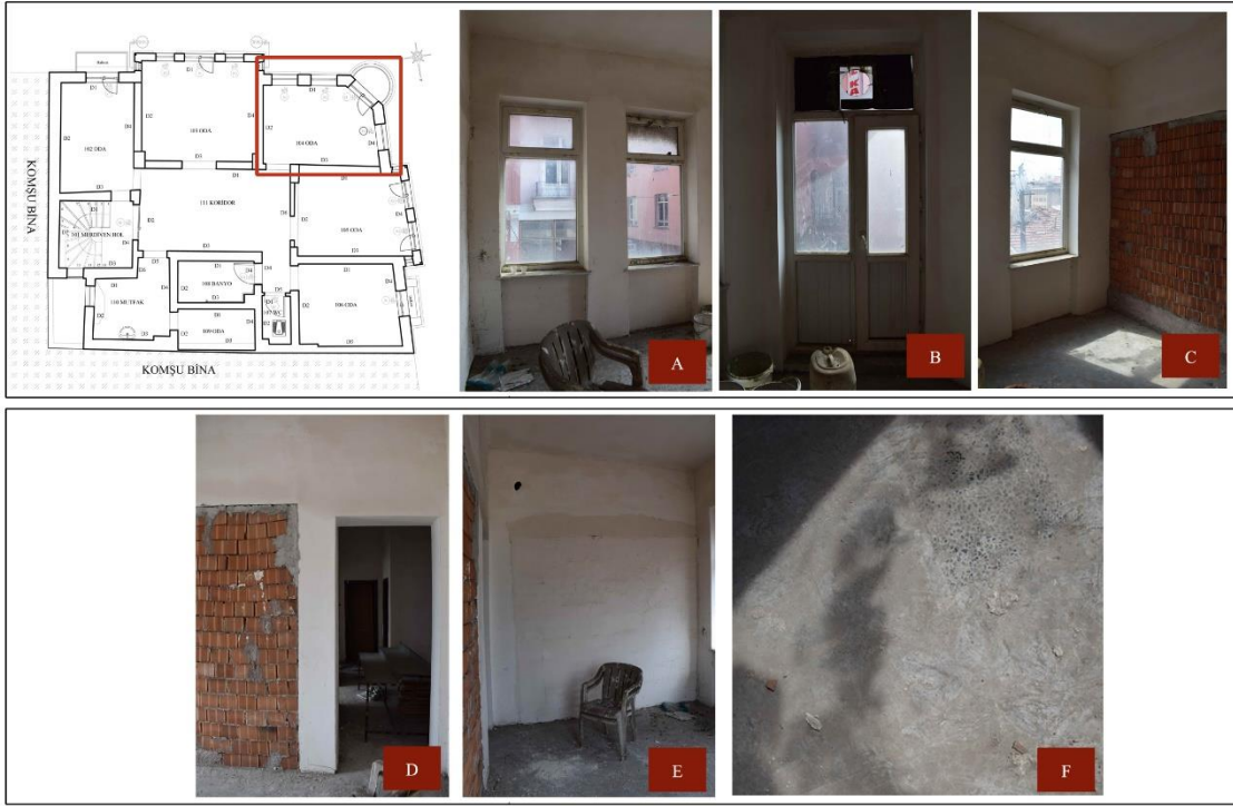
Resim 4.10. 104 nolu odaya ait görseller: (A) D1 duvarı pencereler, (B) balkon kapısı K8, (C) D4-D3 duvarı, (D) D3 duvarı ve kapı açıklığı, (E) D2 duvarı, (F) oda zemini
