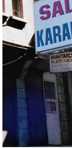
Resim 5.15. 1994 tarihinde yapının giriş kapısı
