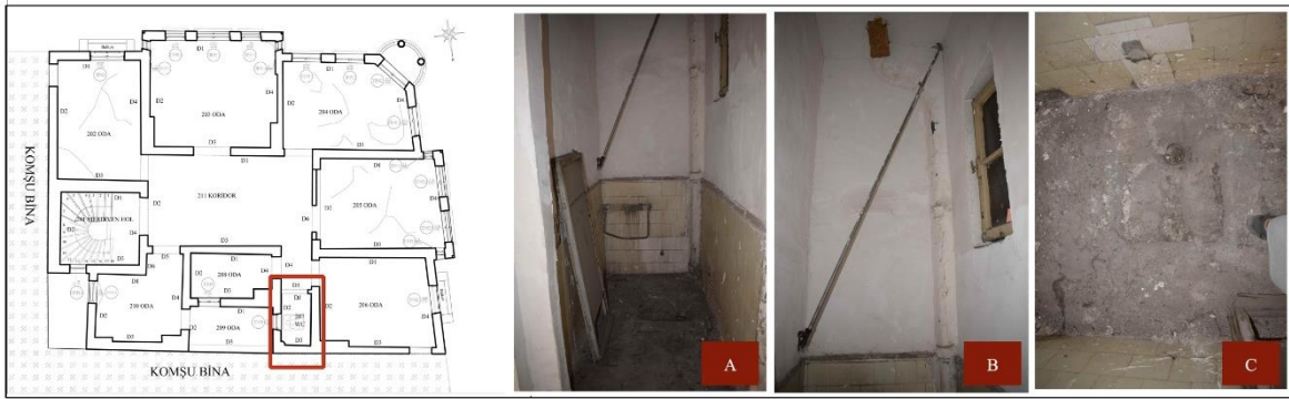
Resim 4.24. 207 nolu WC'ye ait görseller: (A) iç mekan görünümü, (B) D3-D2 duvarı görünümü, (C) mahal zemini
