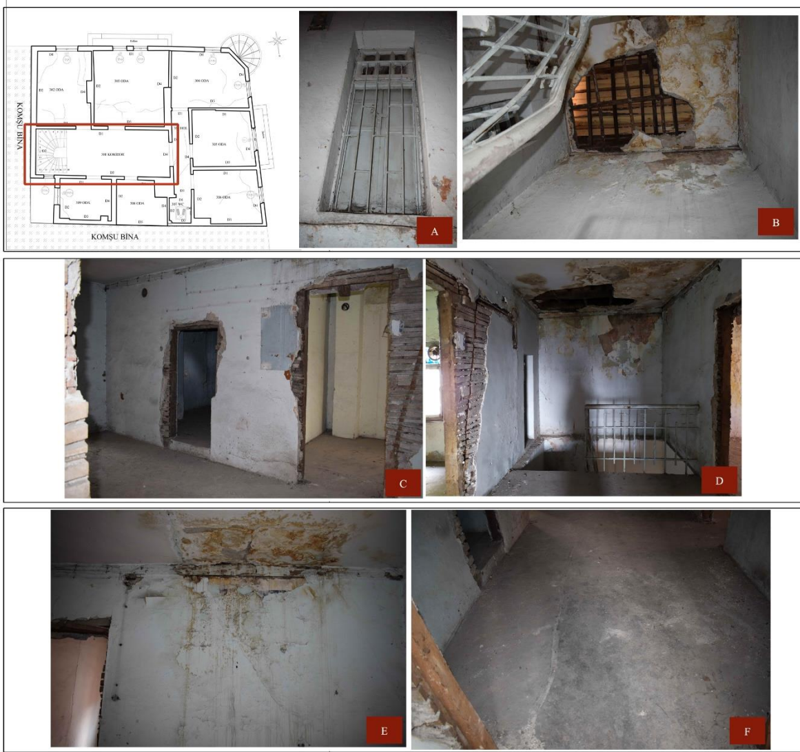
Resim 4.29. 301 nolu koridora ait görseller: (A)mahal penceresi tip-p6, (B)mahal tavanı, (C)D3 duvarı, (D)D2 duvarı, (E)tavan nemlenmesi, (F)mahal zemini
