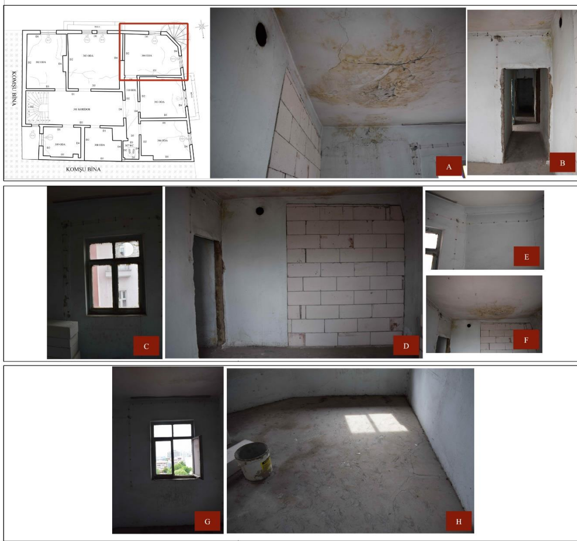
Resim 4.32. 304 nolu odaya ait görseller: (A)oda tavanı, (B)D3 duvarı ve kapı açıklığı, (C)D1 duvarı ve pencere, (D)D2 duvarı, (E)D4 duvarı, (F)oda tavanı, (G)D4 duvarı, (H)oda zemini
