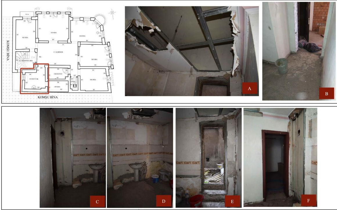
Resim 4.16. 110 nolu mutfağa ait görseller: (A) asma tavan; (B) oda zemini; (C),(D) D3 duvarı; (E) D2 duvarı, (F) D4 duvarı
