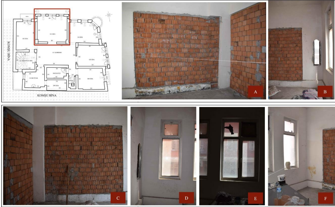
Resim 4.9. 103 nolu odaya ait görseller: (A)D4-D3 duvarı kesişimi; (B)D2 duvarı; (C)D2 duvarı, (D),(E),(F) D1 duvarı pencereleri
