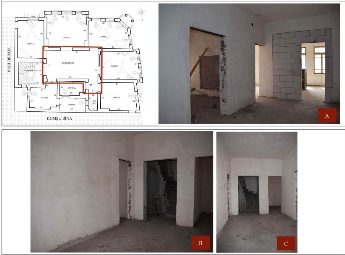
Resim 4.28. 211 nolu koridora ait görseller: (A)D1-D6 duvarları, (B)D2-D3 duvarları, (C)D2 duvarı
