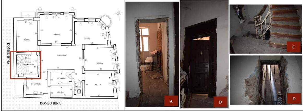
Resim 4.7. 101 merdiven holü görselleri: (A)102 nolu odaya geçiş açıklığı, (B)111 nolu koridora geçiş çelik kapı, (C) hol zemini, (D)pencere açıklığı
