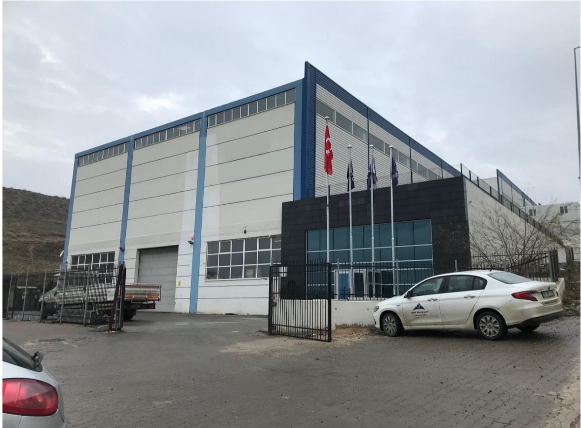
Resim 5.1. Örneklem olarak seçilen preshane binası
