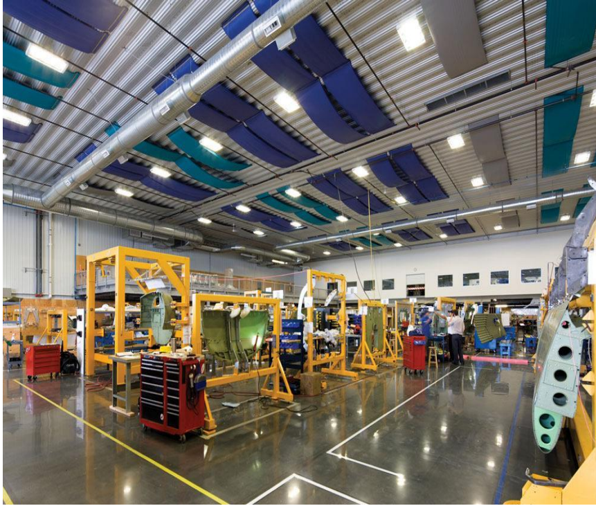
Resim 3.1. Bir fabrikada ses yutucu malzemelerin kullanımı (canadianmetalworking.com)
