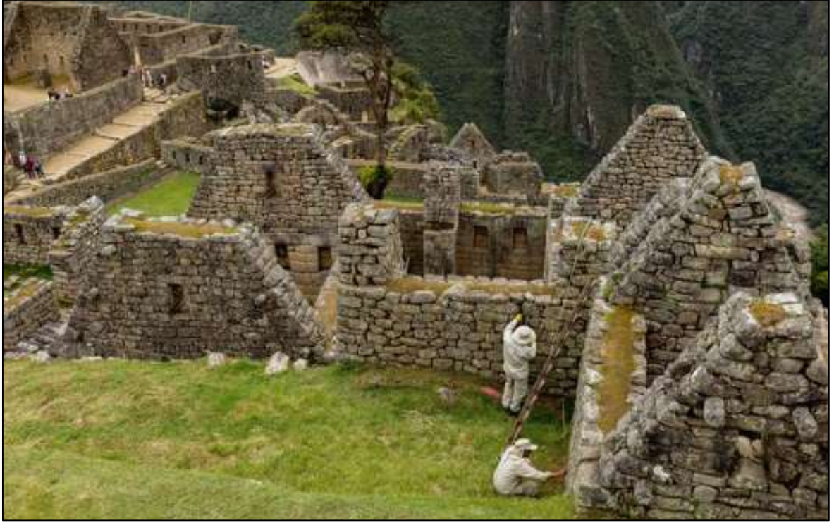
Resim 4.4. Machu Picchu'da restorasyon çalışmaları (Restoration work Machu Picchu Peru stock photos and images, 2019)
