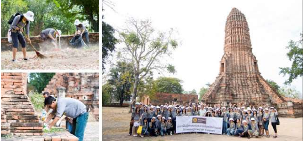
Resim 4.3. Ayutthaya'da restorasyon çalışmaları (The preservation of Ayutthaya, 2012)
