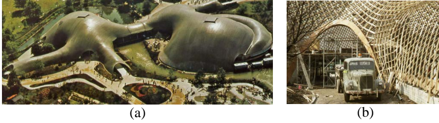
Resim 3.11. (a) Mannheim Multihalle yapısının kuşbakışı görünümü, (b) Yapının strüktür inşası (Liddell, 2015)
