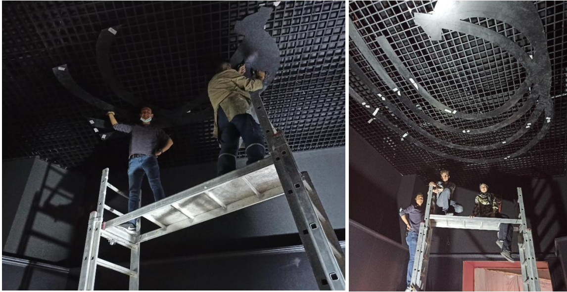
Resim 4.8. Tavan levhasının montajını yapan Sezens Mimarlık ekibi (Fotoğraflar yazar tarafından çekilmiştir)
