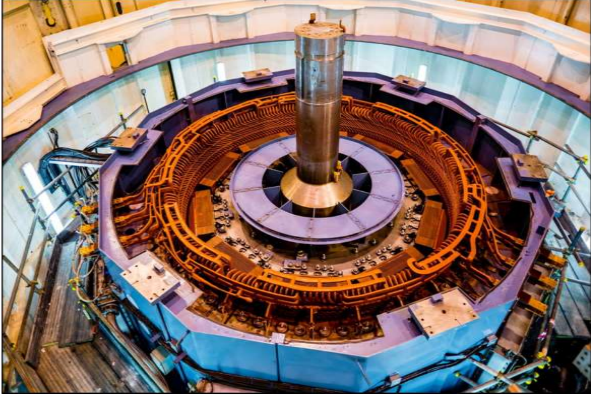
Resim 2.1. Bir hidroelektrik santraldeki senkron generatör [41]
