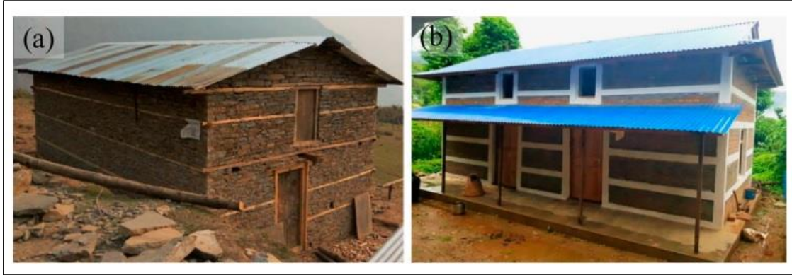
Resim 3.10. (a) Ahşap sismik bantlı çamur harçlı taş duvar işçiliği ve (b) RCC sismik bantlı çimento harçlı tuğla duvar işçiliği kullanılan kırsal kesimlerde yeniden inşa edilen tip konutlar (Acharya ve diğerleri,2015: 600)
