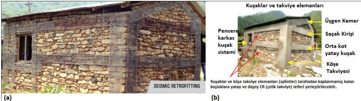
Resim 4.3. (a) Gorkha Depremi sonrası onarım yapılan yığma konut (b) Aynı konutun onarım yapılmış durumu (National Reconstruction Authority, 2021: 292,360)
