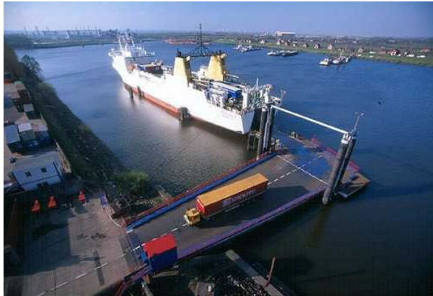
Resim 1.13. Hamburg Limanı, Ro-Ro Terminali, Almanya
