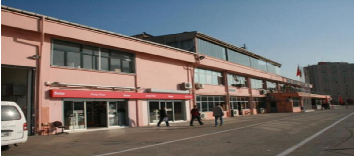
Resim 4.9. İzmir Alsancak Limanı terminal binası (Oral, E.Z., Özerden, A., 2010)
