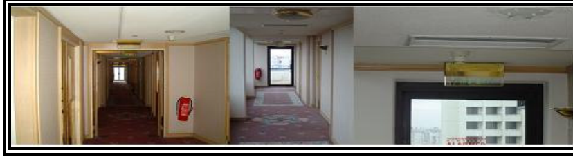
Resim 6.2. Yatak katı koridoru: duman dedektörü, sesli alarm, işaretler
