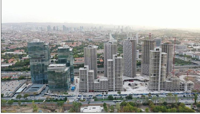
Resim 2.2. Merkez Ankara konutlarından bir görünüm ( https://www.emlakkonut.com.tr/ )
