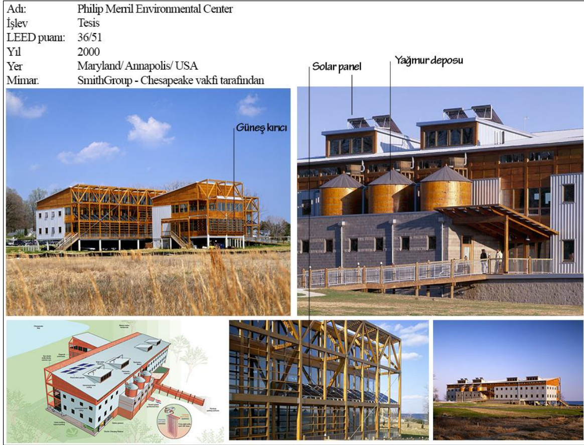
Resim 2.11. Dünyanın ilk LEED+NC platin sertifikası alan binası (URL-19)
