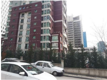
Resim 5.16. 7-25; Zemin Katta Sokak ile Etkileşim kriterini barındırmayıp Yapı Çevresinde Peyzaj Alanı kriterini barındıran çözüm; Hayat Sebla Konutları
