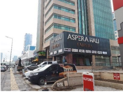
Resim 5.20. 21-25; Yapı İçinde Zemin Katta Kamusal Alan kriterini barındırıp Yapı Çevresinde Peyzaj Alanı kriterini barındırmayan çözüm; Hayat Plaza
