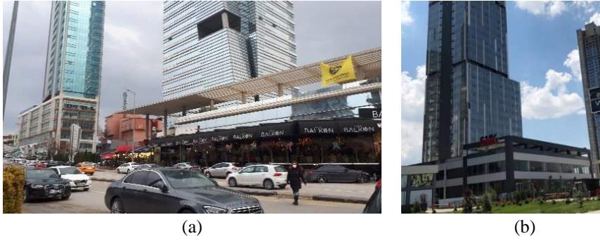
Resim 5.5. 2-13; Geri Çekme ve Baza ile Kule Arasında Belirgin Ayrım kriterlerini barındıran çözümler; (a) Paragon Tower (b) SMK Tower (URL-43)
