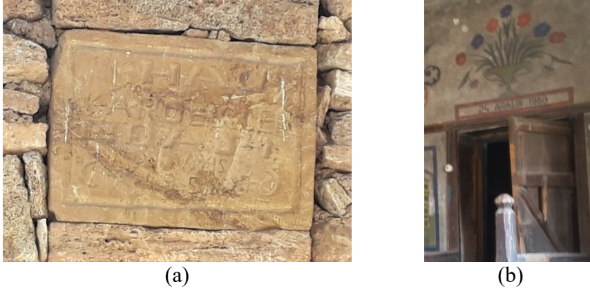
Resim 3.4. a, Gaziköy Köy Odası İnşa Tarihi Yazılı Kitabe; b, Gözmen Hacı Halillerin Odası İnşa Tarihi
