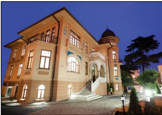
Resim 5.38. Mongeri Binası’nın güney cephesi (Algan, 2024)
