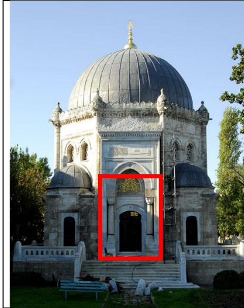
Resim 5.15. Sultan V. Mehmed Reşad Türbesi'nin giriş cephesi (Cambaz, 2009)
