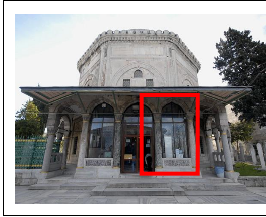
Resim 5.6. Kanuni Sultan Süleyman Türbesi'nin giriş revakı sütun (Cambaz, 2010)
