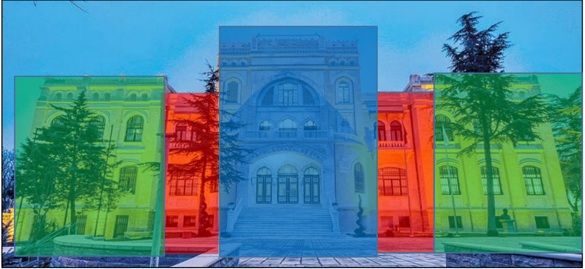
Resim 4.6. Türk Ocakları Merkez Binası giriş cephesi simetrik bölümler (Cennet Ceylan Kişisel Arşivi, 2023)
