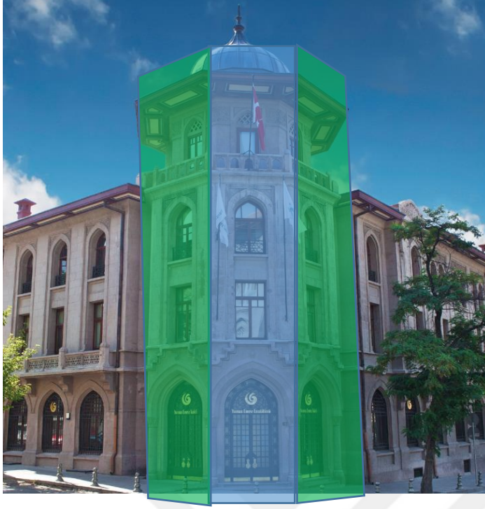
Resim 4.8. Tekel Binası giriş cephesi simetrik bölümler (Cennet Ceylan Kişisel Arşivi, 2023)
