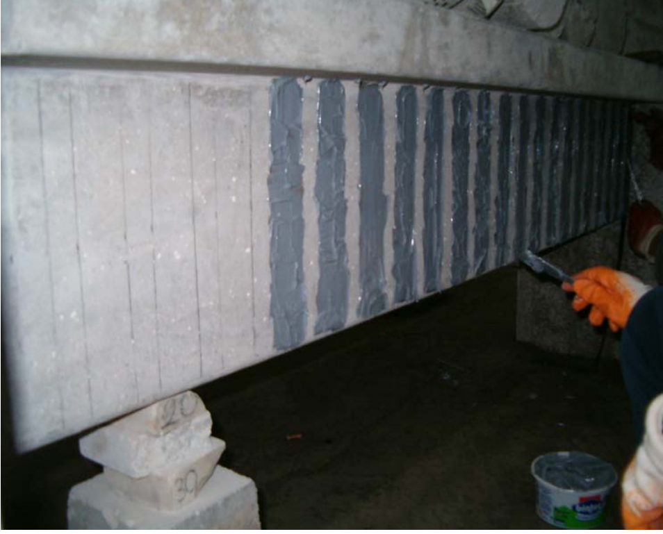
Resim2.10. Epoksinin sürülmesi
