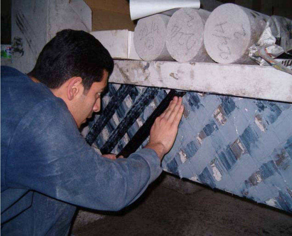
Resim 2.11. CFRP şeritlerin yapıştırılması
