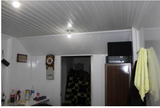
Resim 7.4 (a) ve (b). Protesis bölümünde muhdes bölme protesis odası ahşap tavan
