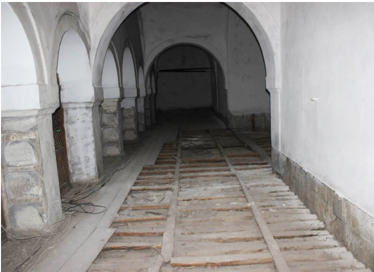
Resim 5.79. Zemin ahşap kiriş üzeri ahşap kaplama
