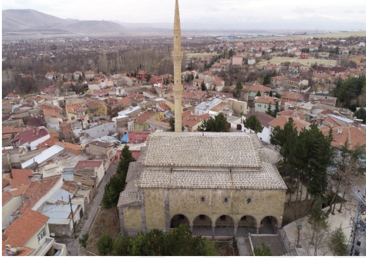
Resim 5.22. Fertek Kilisesi'nin kuzey cephesi
