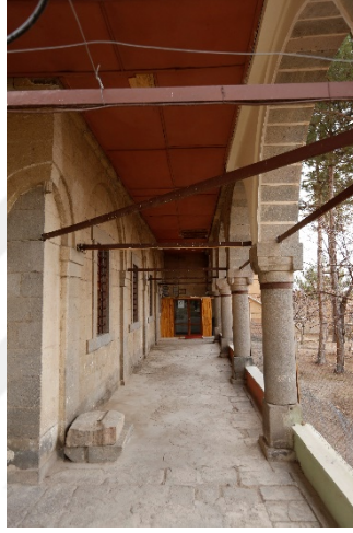
Resim 7.1 (a) ve (b). Narteks tavan kaplaması ve narteks bozulan taş zemini
