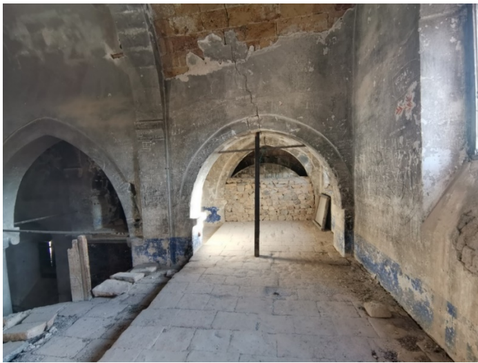
Resim 6.255. Galeri katında askeri depo olarak kullanılan zamanda yıpratılan kemer
