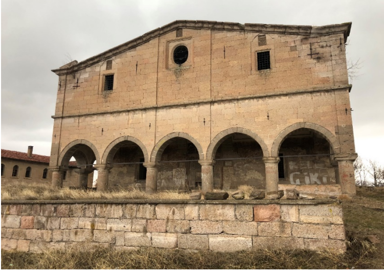
Resim 6.53. Yanartaş Kilisesi'nin batı cephesi
