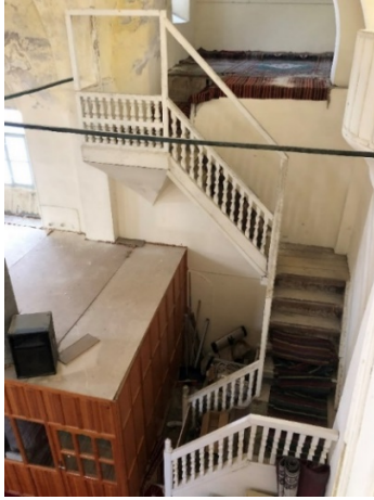
Resim 6.114. (a) ve (b). Galeri katına çıkan ahşap merdiven ve ahşap korkulukları
