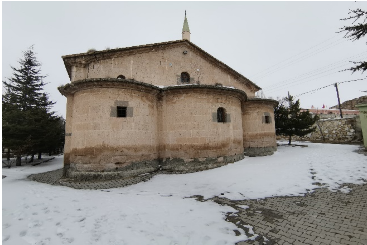
Resim 6.120. Aktaş Kilisesi'nin doğu cephesi
