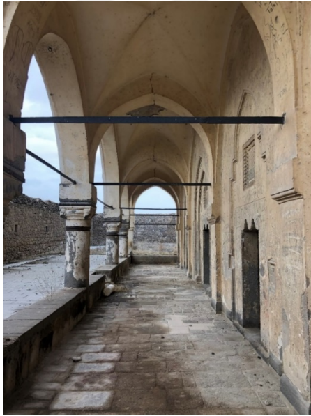
Resim 6.154. Konaklı Rum Kilisesi'nin narteks bölümü
