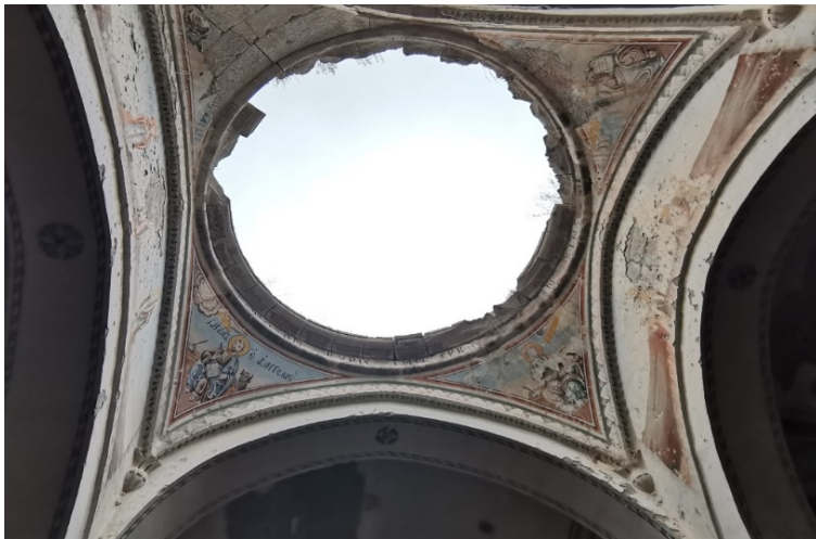
Resim 6.61. Yanartaş Kilisesi'nin naos bölümü üzerindeki yıkılan kubbe
