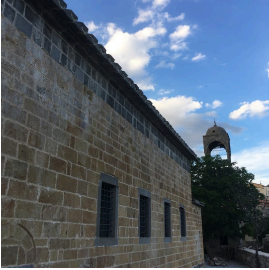
Resim 6.294. Niğde Yeşilburç Kilisesi güney cephesi [66]
