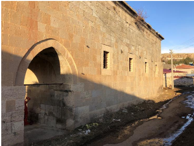
Resim 6.260. Dikilitaş Kilisesi'nin güney cephesi
