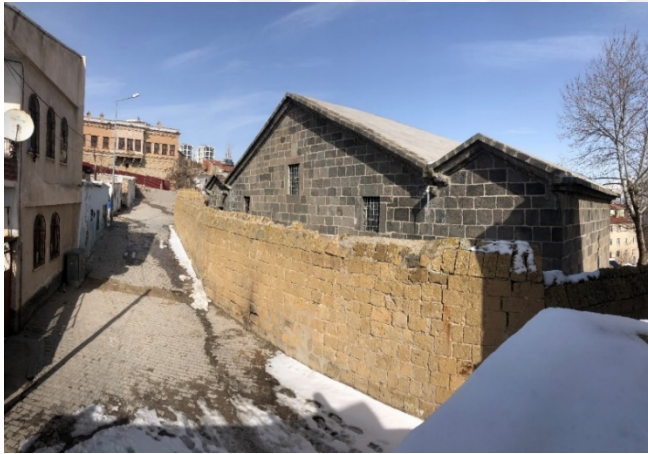
Resim 6.102. Aşağı Kayabaşı Kilisesi'nin batı cephesi
