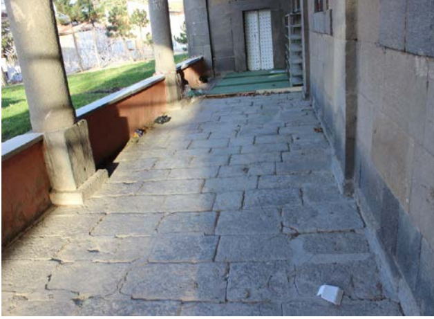
Resim 5.38. Fertek Kilisesi'nin narteks bölümü yer döşemeleri
