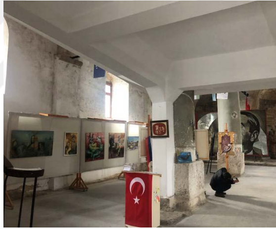
Resim 6.288. (a) ve (b). Naos bölümü ve sonradan eklenen betonarme kolon ve kirişler
