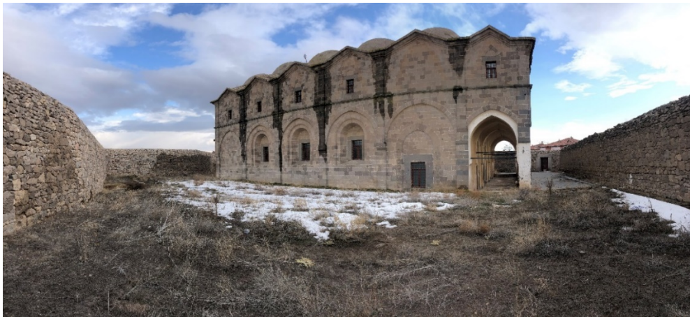
Resim 6.149. Konaklı Rum Kilisesi'nin kuzey cephesi
