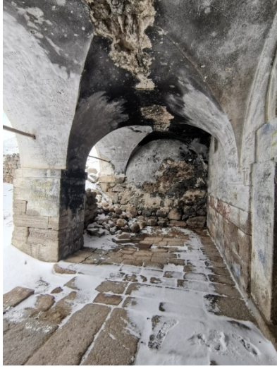
Resim 6.221. Küçükköy Kilisesi'nin narteks bölümü
