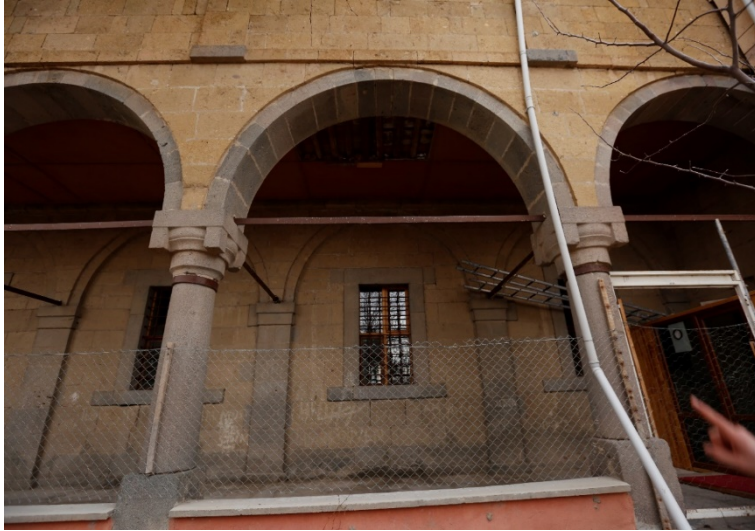
Resim 5.19. Fertek Kilisesi'nin gney cephesinde bulunan lokma demirler
