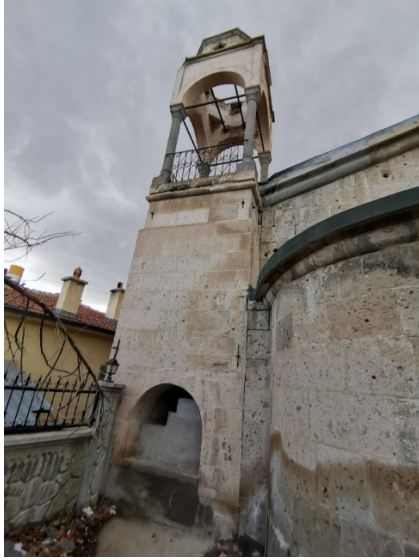
Resim 6.216. Ovacık Kilisesi'nin çan kulesi
