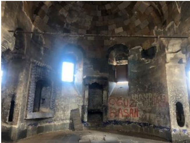
Resim 6.252. Hamamlı Kilisesi'nin apsis bölümünde bulunan nişler
