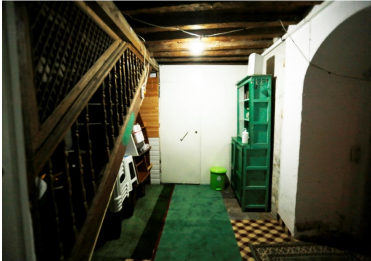
Resim 5.67. Z05-Z06 bölüm arası ahşap bölme duvar
