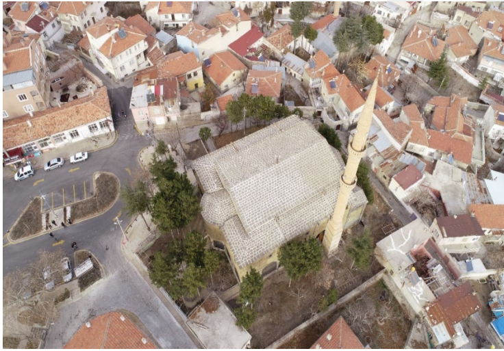
Resim 5.35. Fertek Kilisesi'nin çatısı
