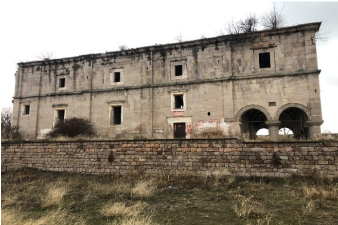
Resim 6.55. Yanartaş Kilisesi'nin kuzey cephesi
