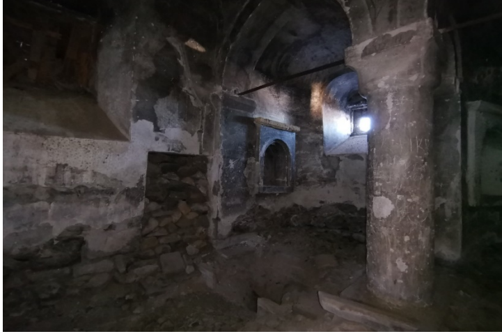
Resim 6.143. Ballı Kilisesi'nin kuzey cephesi yonu taşla kapatılan kapı ve apsis nişi
