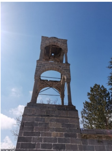
Resim 6.296. Niğde Yeşilburç Kilisesi çan kulesi [66]
