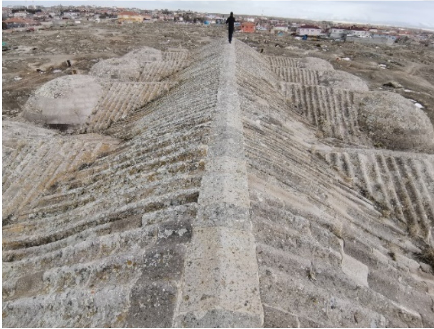
Resim 6.158. Konaklı Rum Kilisesi'nin çatısı
