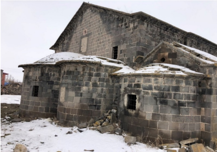
Resim 6.170. Hasaköy Kilisesi'nin doğu cephesi
