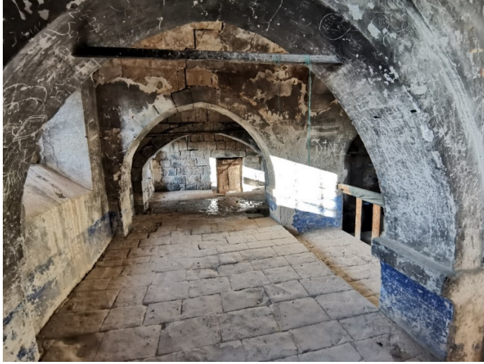
Resim 6.256. Hamamlı Kilisesi'nin galeri katı zemini
