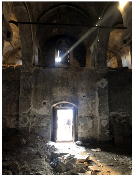
Resim 6.142. Ballı Kilisesi'nin galeri katı bölümü
