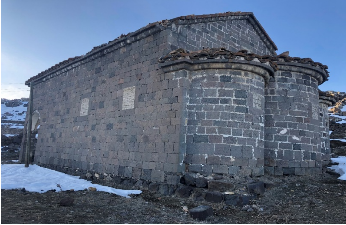
Resim 6.137. Ballı Kilisesi'nin güney cephesi
