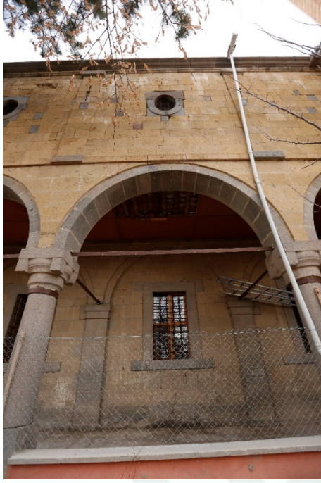
Resim 5.41 (a) ve (b). Fertek Kilisesi'nin sivri kemerleri, gergi çubukları, pencereleri
