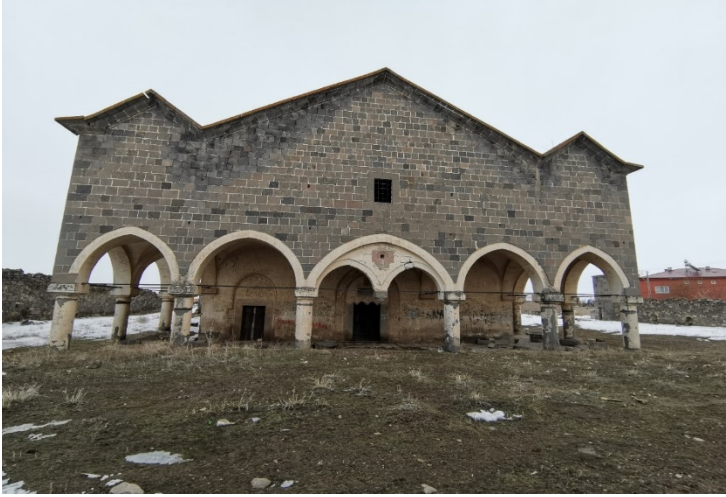
Resim 6.168. Hasaköy Kilisesi'nin batı cephesi
