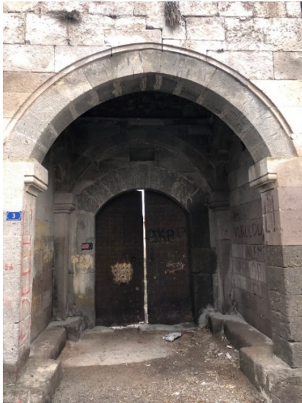
Resim 6.73. Yanartaş Kilisesi kompleksine ana girişi sağlayan büyük avlu kapısı
