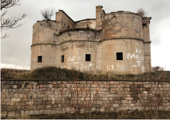
Resim 6.54. Yanartaş Kilisesi'nin doğu cephesi
