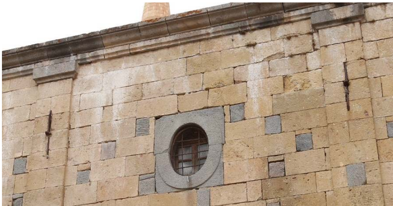
Resim 5.97. Kilisenin kuzey cephesindeki demir kılıçlama
