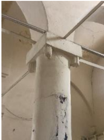
Resim 6.129. (a) ve (b). Aktaş Kilisesi'nin sütun başlıkları ve sıva dökülmeleri
