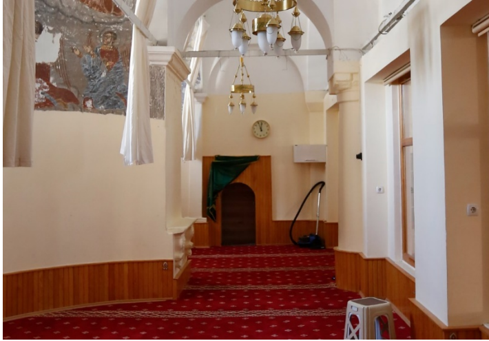
Resim 5.63. K09 kapısı ve duvarlardaki lambri kaplama
