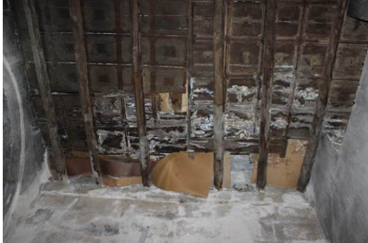
Resim 7.5 (a) ve (b). PVC altındaki ahşap kaplama diakonikon odası
