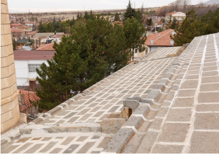
Resim 5.20. Fertek Kilisesi'nin güney cephesinde bulunan çörten
