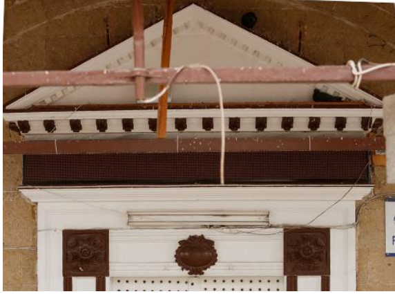
Resim 5.127. Batı cephesi K2 kapısı
