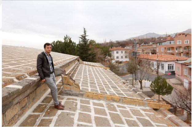
Resim 7.16 (a) ve (b). Fertek Kilisesi Çatısı ve çatıdaki özgün olmayan taş oluk
