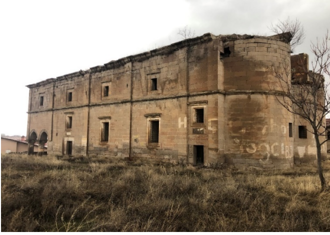
Resim 6.56. Yanartaş Kilisesi'nin güney cephesi
