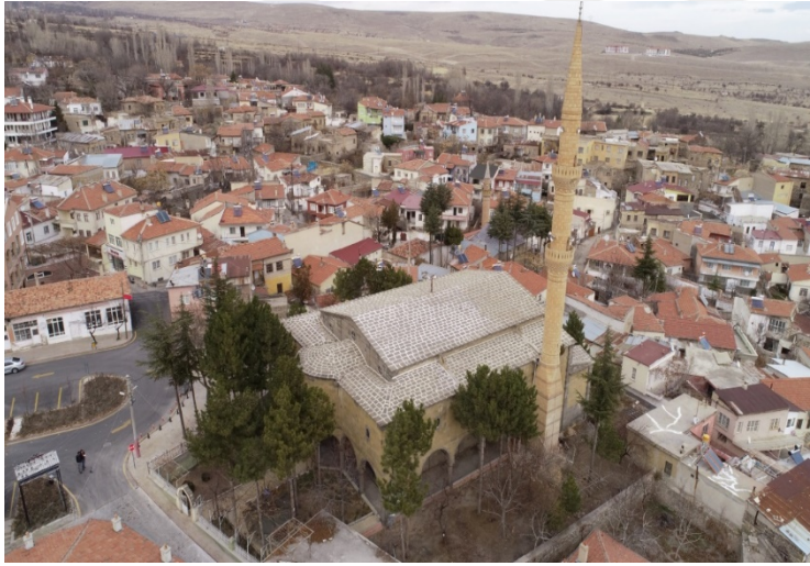
Resim 5.32. Fertek Kilisesi'nin çatısı
