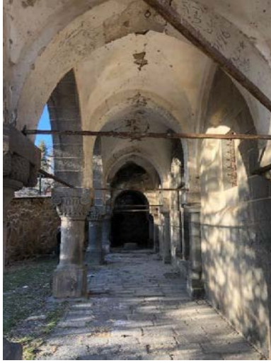
Resim 6.242. (a) ve (b). Narteks bölümünün örtüsü çapraz tonoz ve kubbe
