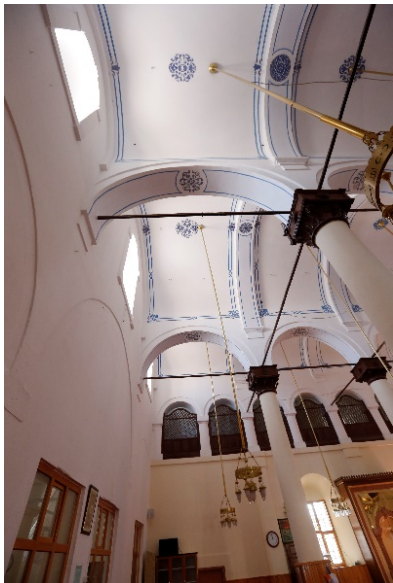
Resim 5.85. Kilise içerisindeki alçısız kaplı taşlar
