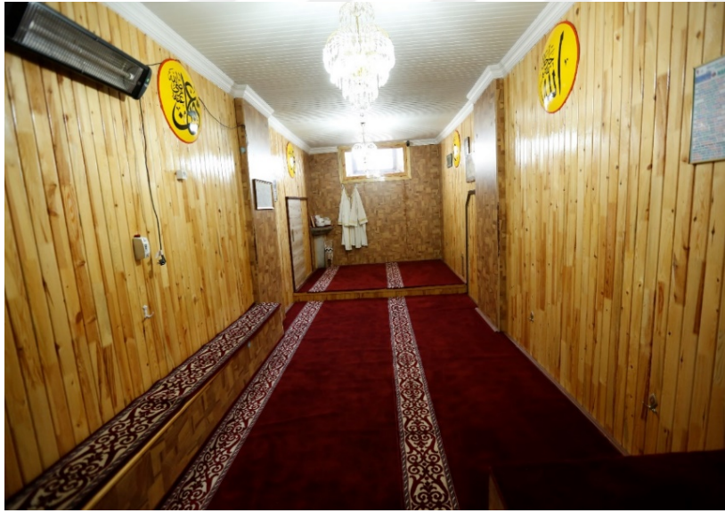
Resim 5.53. Z03 bölümü tavan ve duvar kaplamaları
