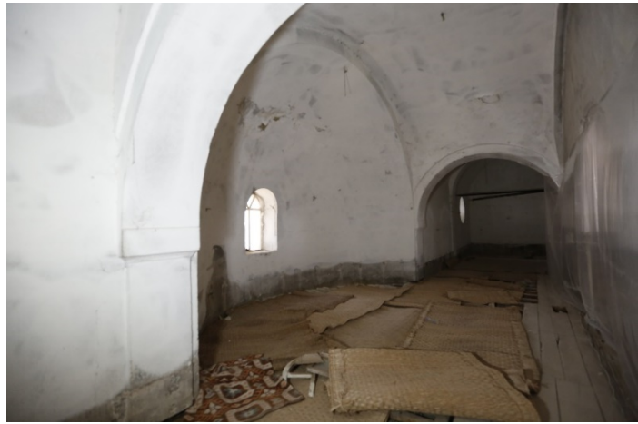
Resim 5.103 (a) ve (b). Apsis üzeri yarım kubbe ve galeri katı üzeri yarım kubbe
