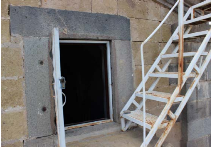
Resim 5.30. Fertek Kilisesi'nin dođu cephesinde bulunan çatıya çıkış kapısı
