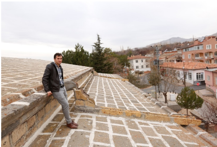
Resim 5.33. Fertek Kilisesi'nin çatıdaki çörtenler
