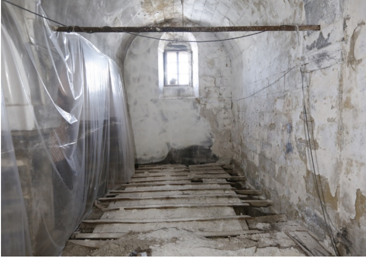
Resim 5.91. Kilisenin galeri bölümü zemin döşemesi
