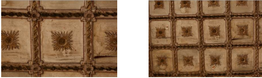
Resim 5.125. Narteks bölümü kuzey cephesi ahşap tavan işlemleri
