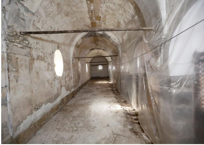
Resim 5.74. Kemerler arası gergi çubukları
