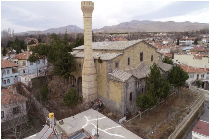
Resim 5.28. Fertek Kilisesi doğu cephesi
