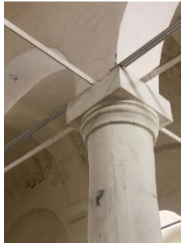
Resim 6.129. (a) ve (b). Aktaş Kilisesi'nin sütun başlıkları ve sıva dökülmeleri
