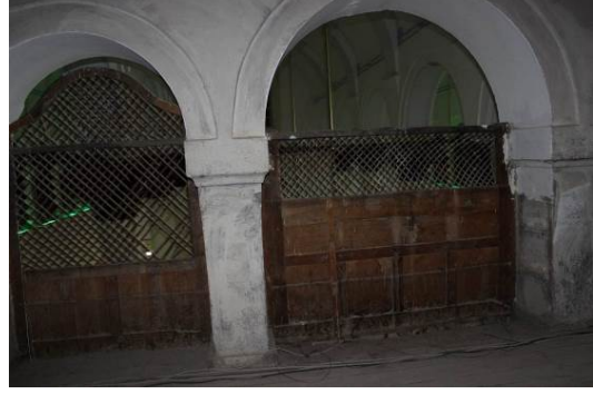
Resim 7.6 (a) ve (b). Galeri bölümü ahşap kaplama ve korkuluktaki muşabak
