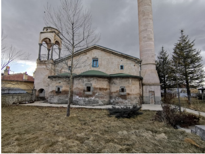
Resim 6.205. Ovacık Kilisesi'nin doğu cephesi
