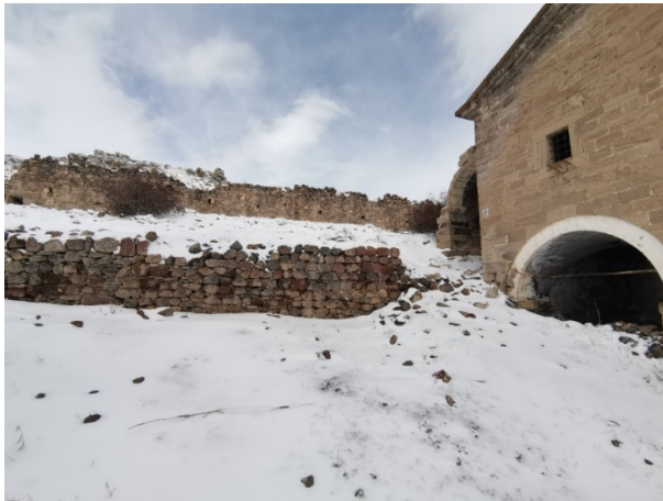
Resim 6.235. Küçükköy Kilisesi'nin avlu duvarı
