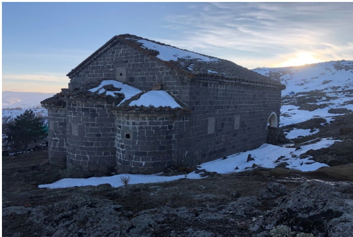
Resim 6.136. Ballı Kilisesi'nin doğu cephesi
