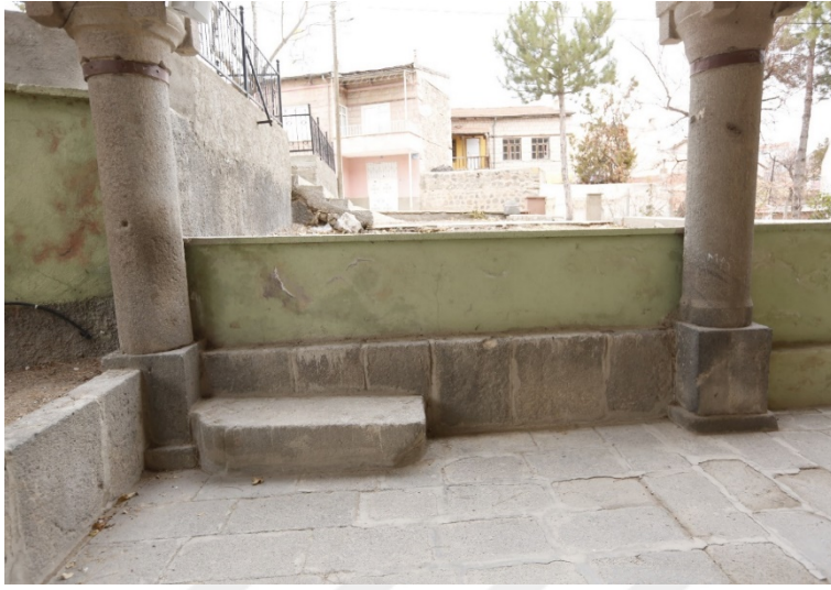
Resim 5.89. Kilisenin narteks bölümü zemin döşemesi
