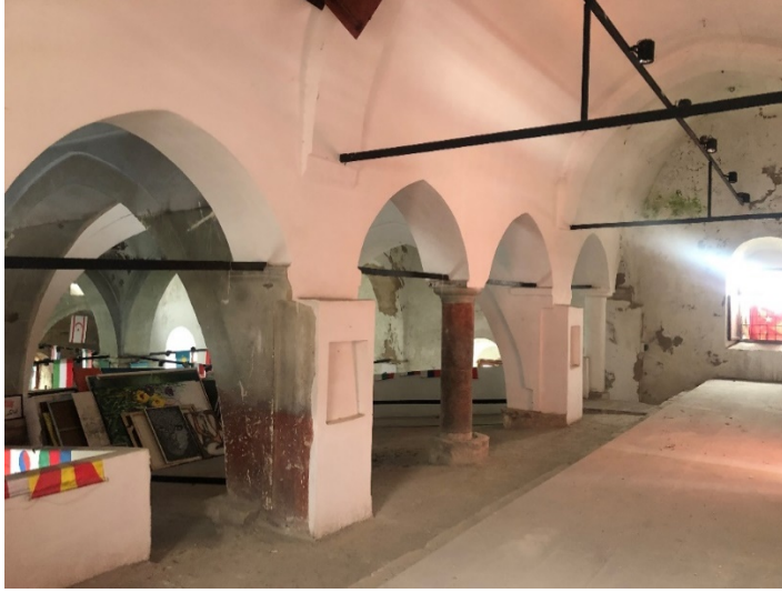
Resim 6.287. Sonradan inşa edilen ilave galeri katı bölümüyle mevcut galeri katı
