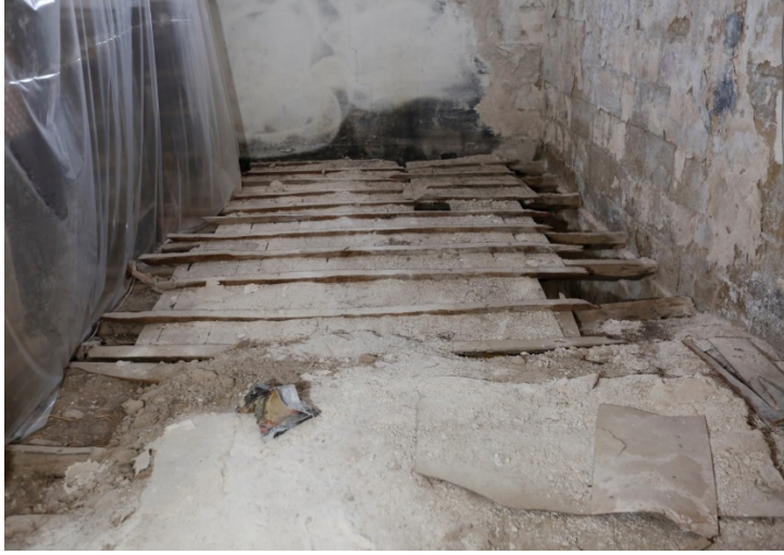
Resim 5.80. Zemin ahşap üzeri toprak kaplama
