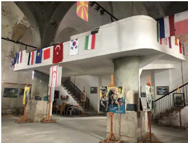
Resim 6.283. Sonradan inşa edilen galeri katına ilave yapılan betonarme bölüm
