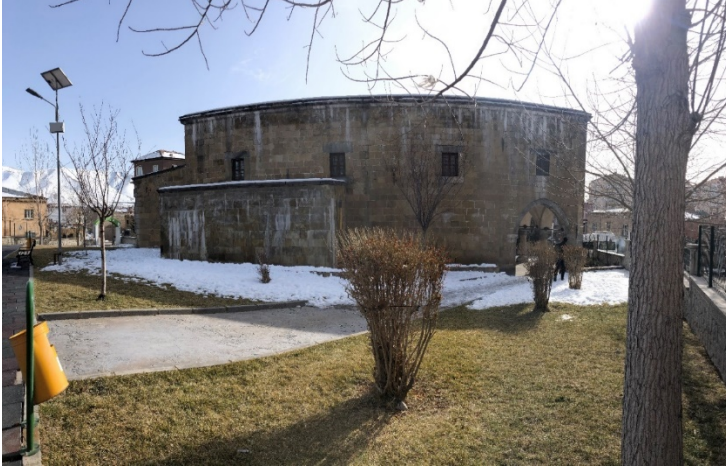
Resim 6.91. Ermeni Kilisesi'nin kuzey cephesi
