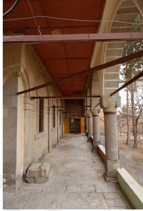
Resim 5.41 (a) ve (b). Fertek Kilisesi'nin sivri kemerleri, gergi çubukları, pencereleri
