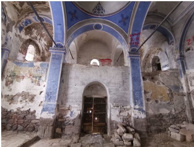
Resim 6.229. Küçükköy Kilisesi'nin galeri katı bölümü
