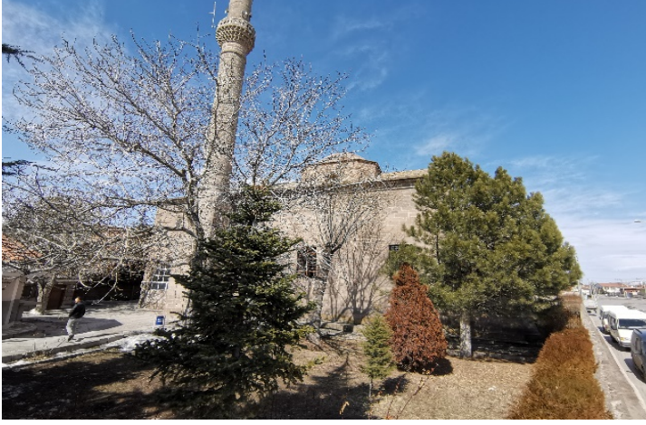
Resim 6.24. Başmelekler Kilisesi'nin güney cephesi
