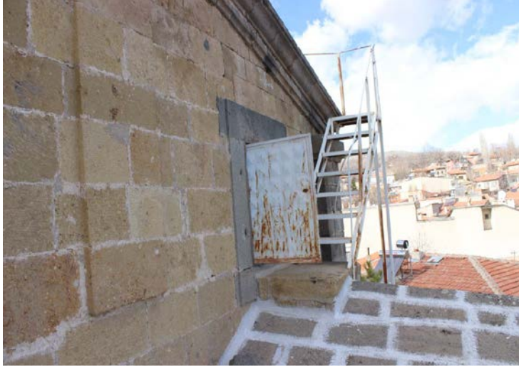
Resim 5.34. Fertek Kilisesi'nin çatıya çıkış sağlayan merdiven
