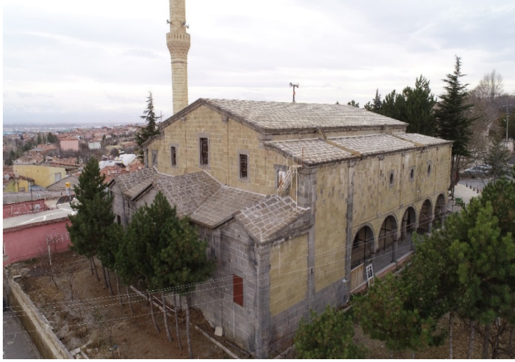
Resim 5.29. Fertek Kilisesi dođu cephesi
