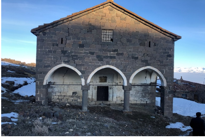
Resim 6.134. Ballı Kilisesi'nin batı cephesi
