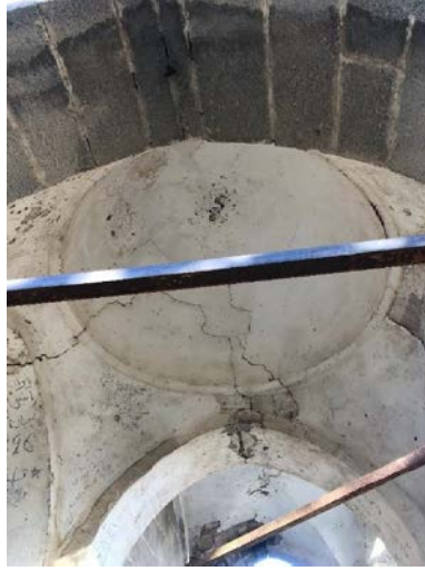
Resim 6.242. (a) ve (b). Narteks bölümünün örtüsü çapraz tonoz ve kubbe
