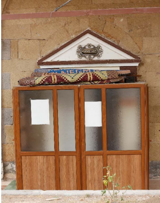
Resim 5.13. Fertek Kilisesi'nin batı cephesi K1 ana giriş kapısı
