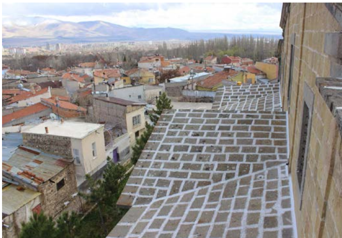
Resim 5.36. Fertek Kilisesi'nin çatısı
