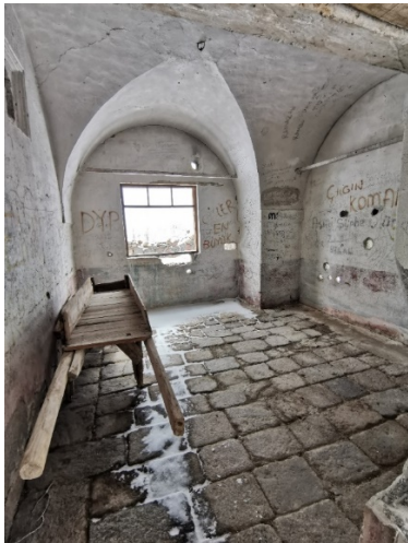
Resim 6.223. Küçükköy Kilisesi'nin narteks bölümünün kapatılan bölümü
