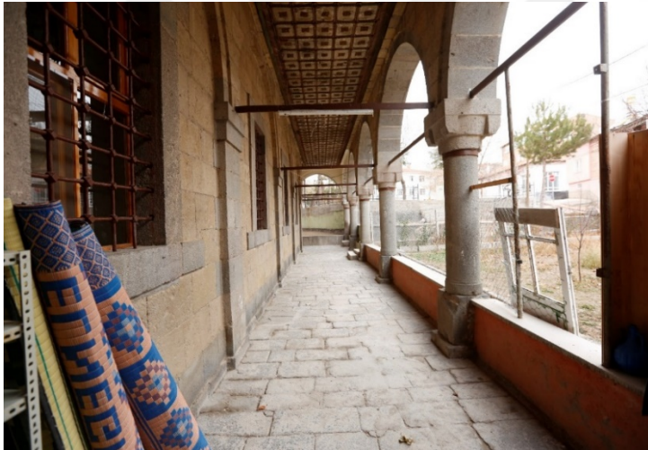
Resim 5.25. Ferteek Kilisesi'nin kuzey cephesinde bulunan lokma demirler
