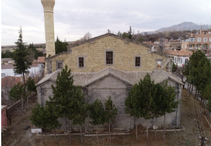
Resim 5.27. Fertek Kilisesi doğu cephesi
