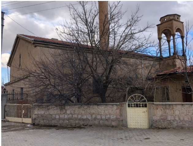
Resim 6.207. Ovacık Kilisesi'nin güney cephesi
