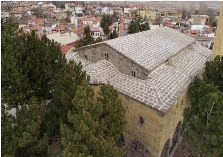
Resim 5.15. Ferteke Kilisesi'nin batı cephesi naosa bakan pencereler
