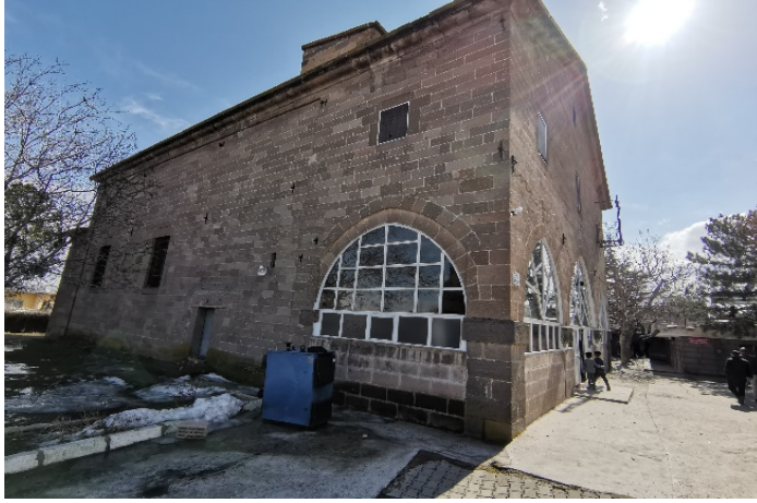
Resim 6.22. Başmelekler Kilisesi'nin kuzey cephesi
