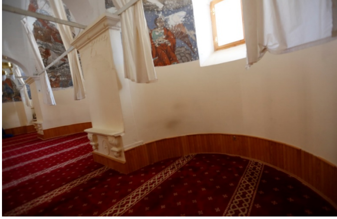
Resim 5.60. Apsis içerisinde duvarlar alçı sıva ve boya kaplama
