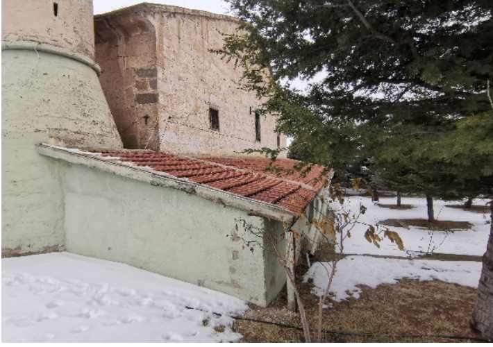
Resim 6.124. Aktaş Kilisesi'nin narteks bölümü çatısı
