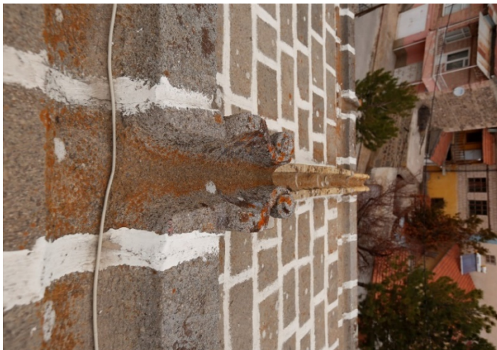
Resim 5.26. Ferteek Kilisesi'nin kuzey cephesinde bulunan çörten
