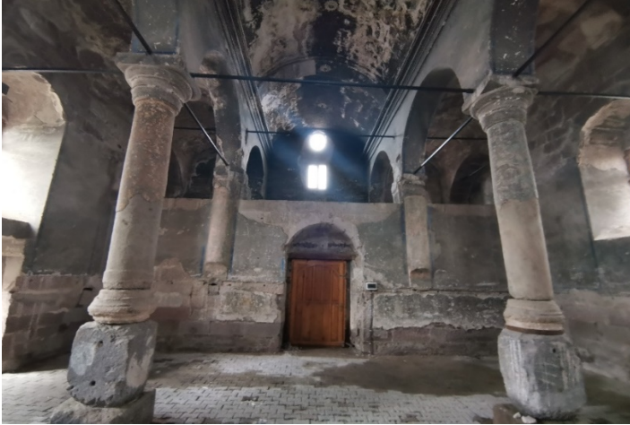
Resim 6.45. Agios Prokopios Kilisesi'nin narteksten naos bölümüne giriş kapısı
