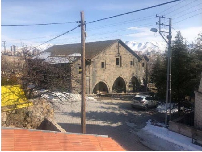
Resim 6.236. Hamamlı Kilisesi'nin batı cephesi
