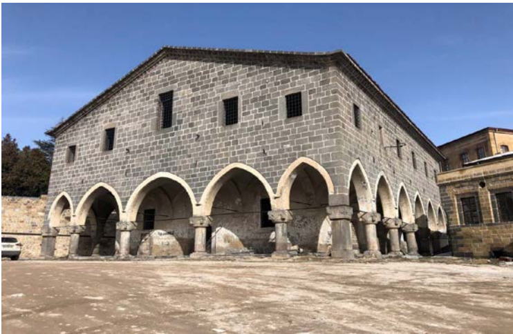
Resim 6.78. H. Prodromos Kilisesi'nin güney cephesi
