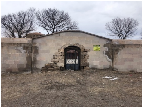
Resim 6.20. Aziz Theodoros Trion Kilisesi'nin avlu duvarı ve girişlerden birisi
