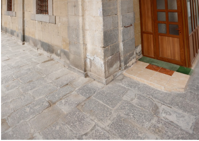
Resim 5.86. Kilise subasman kotundaki renkli kesme taş uygulaması
