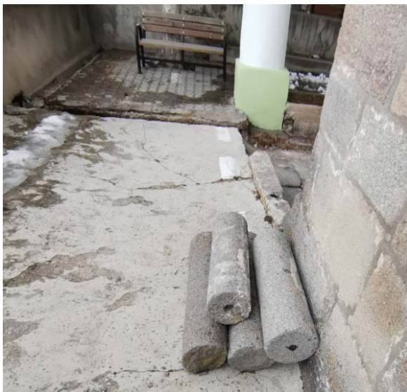
Resim 6.200. Hançerli Kilisesi'nin avlusunda bulunan yıkılan çan kulesi sütunları
