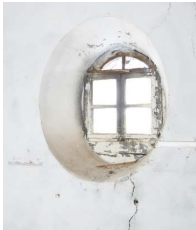
Resim 5.82. Galeriye aydınlatan dairevi ve elips pencereler
