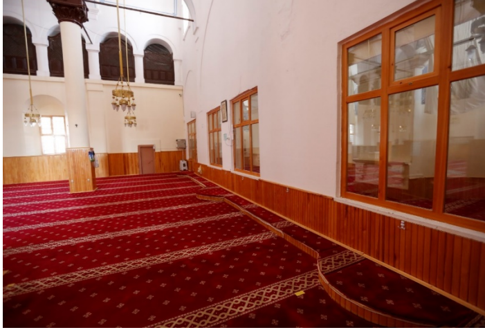
Resim 5.47. Fertek Kilisesi'nin apsis bölümüyle naos bölümü arası muhdes bölme
