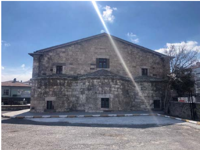
Resim 6.273. Bor Merkez Kilisesi'nin doğu cephesi
