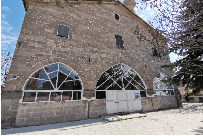
Resim 6.21. Başmelekler Kilisesi'nin batı cephesi
