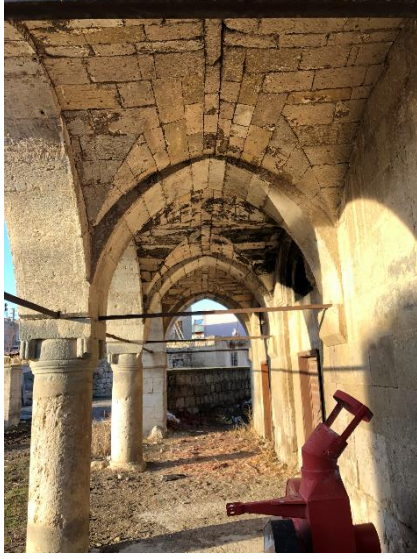
Resim 6.264. Dikilitaş Kilisesi'nin narteks bölümün örtüsü çapraz tonoz
