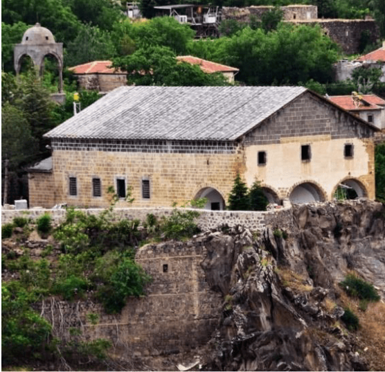
Resim 6.292. Niğde Yeşilburç Kilisesi batı ve kuzey cephesi [66]
