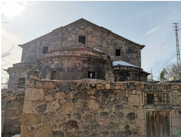
Resim 6.238. Hamamlı Kilisesi'nin doğu cephesi
