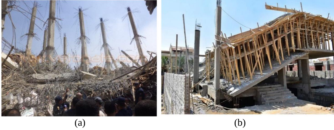
Resim 1.5. Mısır'da (a) bir fabrika binası ve (b) konut inşaatı
