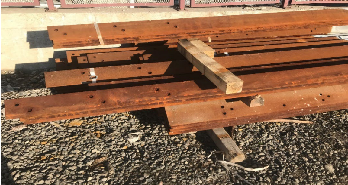
Resim 3.1. Korozyonlu demir köşebent
