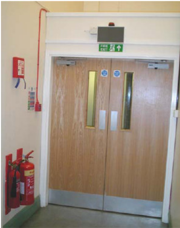
Resim 5.4. Yangın geciktirici ayırıcı bölme nitelikli çıkış kapıları [68]
