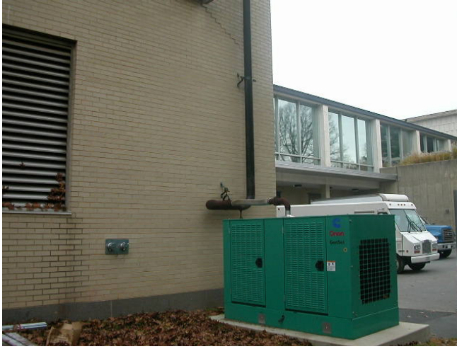
Resim 5.1. Kaçış yolu aydınlatmalarını besleyen jeneratör [81]
