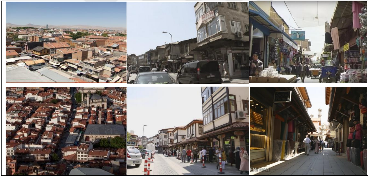
Resim 3.3. Bedesten Çarşısı sağlıklaştırma öncesi (yukarıda) ve sonrasındaki (aşağıda) durumu (Eseroğlu, 2018: 180-191)
