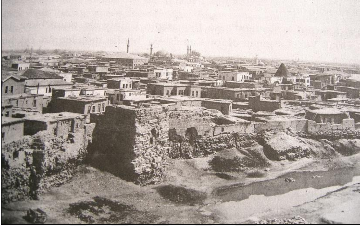
Resim 3.1. Bekir Şahin arşivinden Osmanlı döneminde Şükran Mahallesi ve sur kalıntıları (Toru, 2019)
