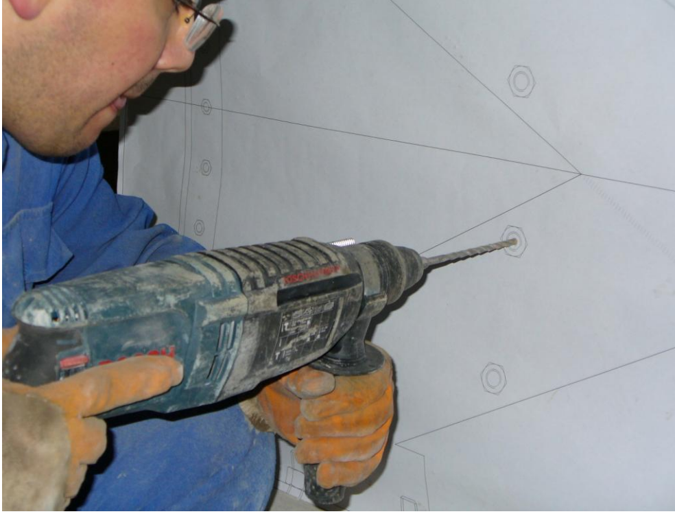
Resim 3.9. Dolgu duvarda deliklerin açılması
