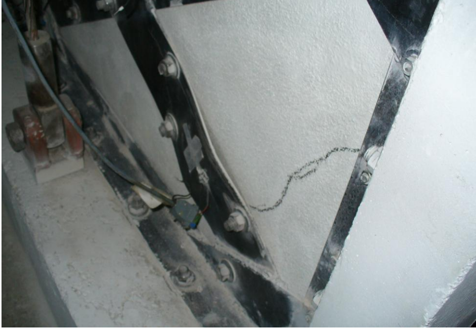
Resim 4.23. 20. çevrim ileri yarı yüklemesi sonunda sol diyagonal şeritte meydana gelen burkulma detayı
