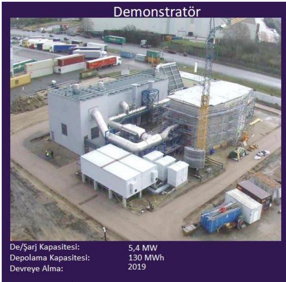
Şekil 1.8. Siemens Gamesa şirketinin 2019 yılında devreye aldığı bir demonstratör Carnot Batarya sistemi ( https://www.strommarkttreffen.org )
