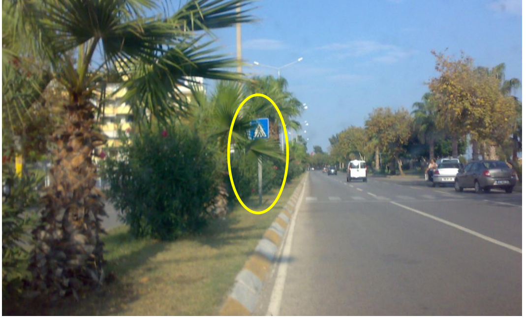
Resim 4: Trafik levhasının ağaçlar tarafından kapatılması sonucu görünürlüğünün azalmasını gösterir fotoğraf Mersin, Türkiye.
