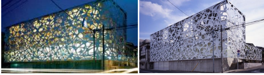
Resim 3.44. Airspace, Thom Faulders tarafından 2007’de tasarlanan cephe, (URL-23)
