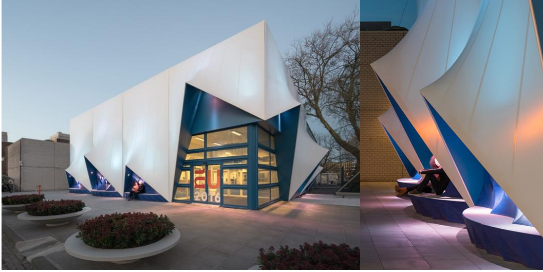
Resim 3.19. 3D yazıcıyla üretilen bina cephesi, DUS Architects, (URL-8)
