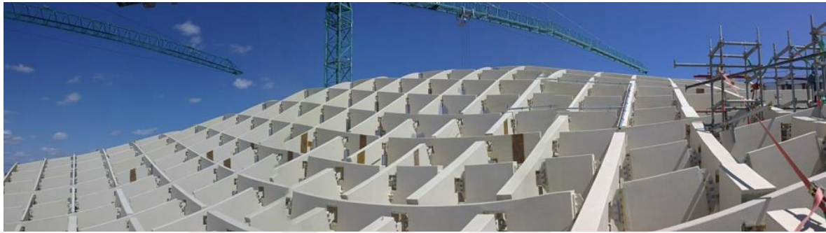
Resim 4.19. Verilen güçlerle eşleşen farklı genişlikteki LVL kirişleri (Koppitz ve diğerleri, 2012)
