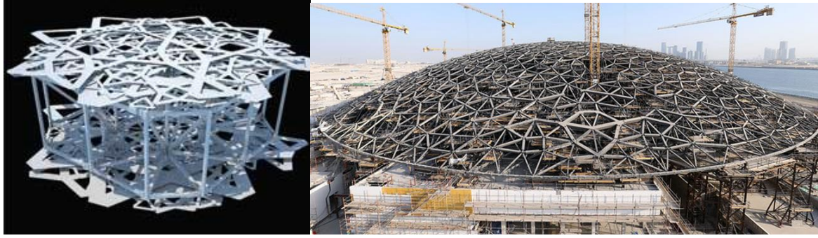
Resim 4.26. Çatının karmaşık kompozisyonunu gösteren dijital model ve yapı aşamasında kubbe (Birch, 2010)
