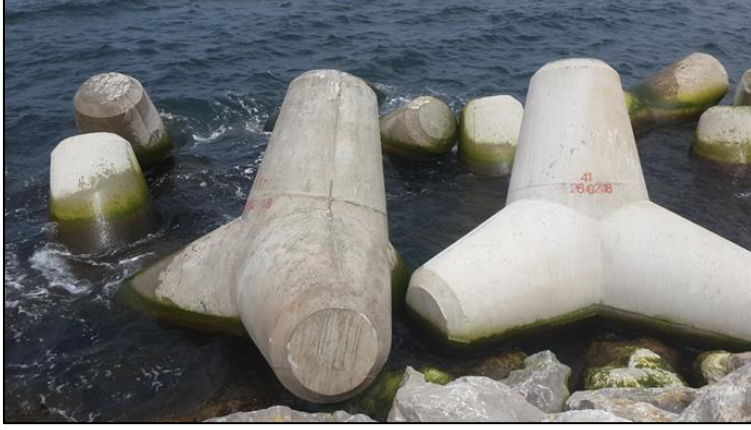
Şekil 5.3. Koruma tabakasında yer alan tetrapodların hasar sonrası durumu
