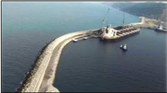
Şekil 5.1. Mendireğin hasar görmeden önceki durumu
