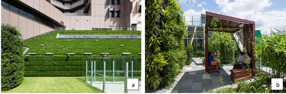
Resim 4.4. (a) Eğimli çatı, (b) çatı bahçesinde sığınma alanından görünüm (URL-34)
