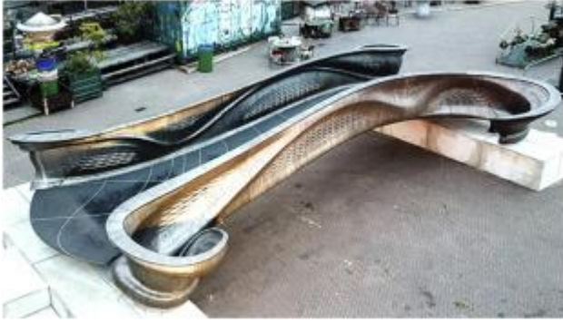
Resim 2.1. Paslanmaz çelik yığılarak WAAM ile üretilen 10,5 metre uzunluğunda bir köprü [4]
