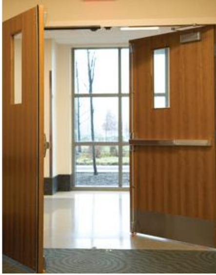
Resim 4.8. Birbirine zıt yönlerde açılan yatay tahliye kapısı [156]
