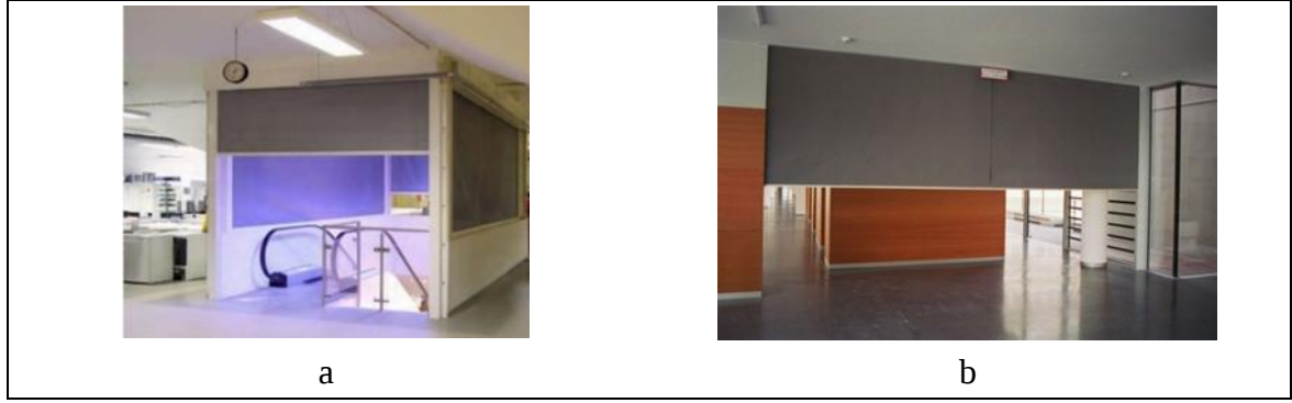
Resim 4.6. a.Yürüyen merdiven çevresinde duman perdesi uygulaması [151], b. Otomatik olarak inen duman perdesinin koridorda kullanılması [152]
