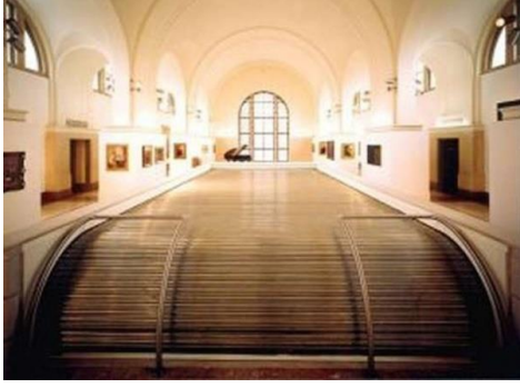
Resim 4.13. Yürüyen merdivenin acil durum esnasında çelik panjurlarla kapatılması [169]
