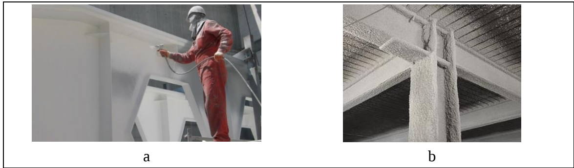
Resim 4.1. a. Çelik strüktürün yangına dayanıklı boya ile boyanması [127] b. Çelik strüktürün yangına dayanıklı püskürtme sıva ile sıvanması [128]
