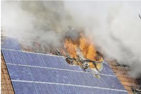
Resim 4.2. Çatıda fotovoltaik panel yangını [137]
