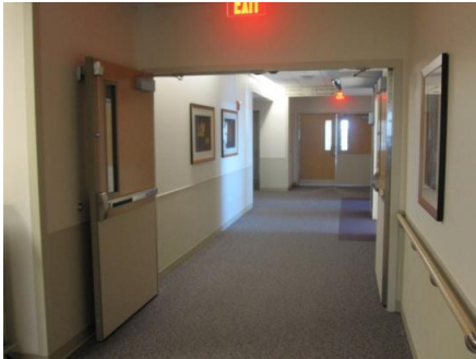
Resim 4.12. Her iki kompartıman yönünde de açılan yatay çıkış kapısı [166]
