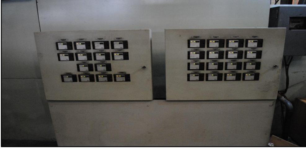
Resim 1.10. Sertleştirme fırını brülör kumanda paneli
