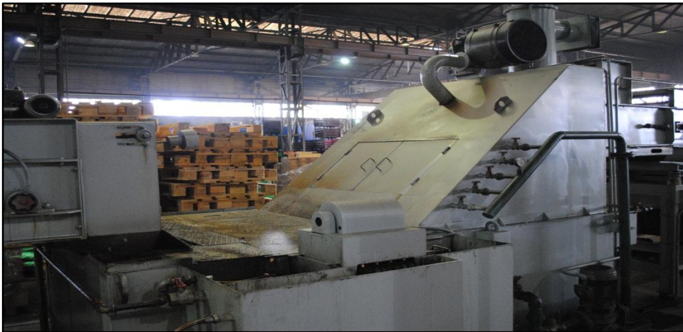
Resim 1.12. Menevişleme fırını öncesi alkali deterjanla yıkama ünitesi
