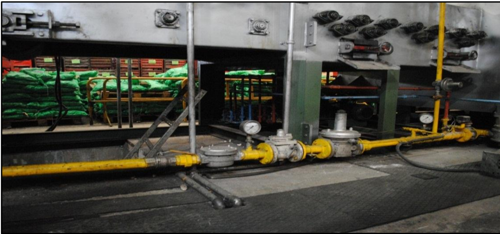
Resim 1.6. Sertleştirme fırını doğal gaz hattı
